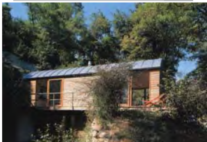
4.33 Edificio residenziale in Francia immerso ombreggiato dalla vegetazione
