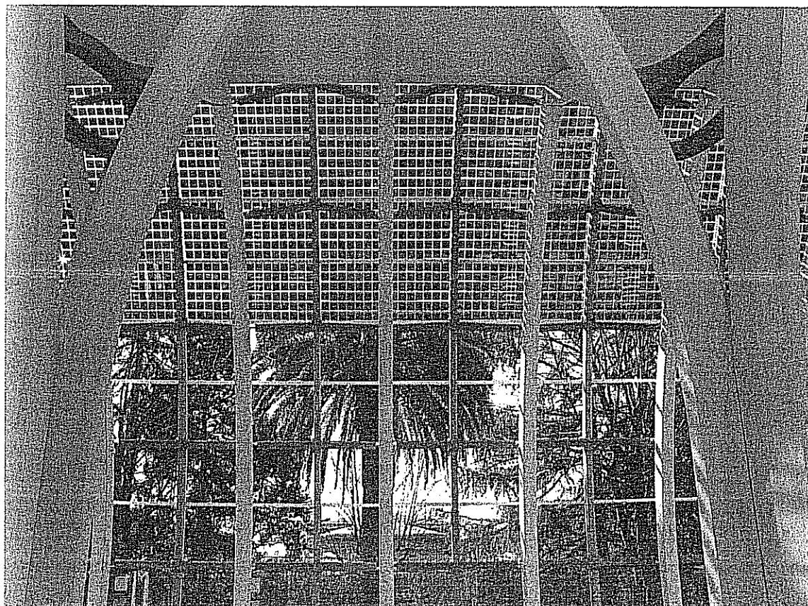
Figura 8. Vista dall'interno della hall fotovoltaica del nuovo Ospedale pediatrico Meyer, Firenze
