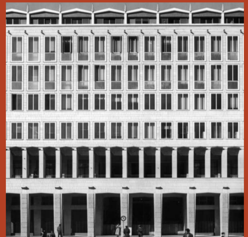
L. Vagnetti, Palazzo Grande, particolare
