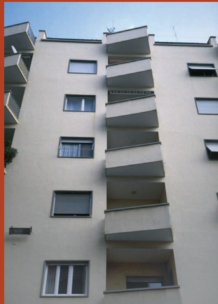
L. Vagnetti, «edificio per abitazioni popolari», fronte su via Piave, particolare
