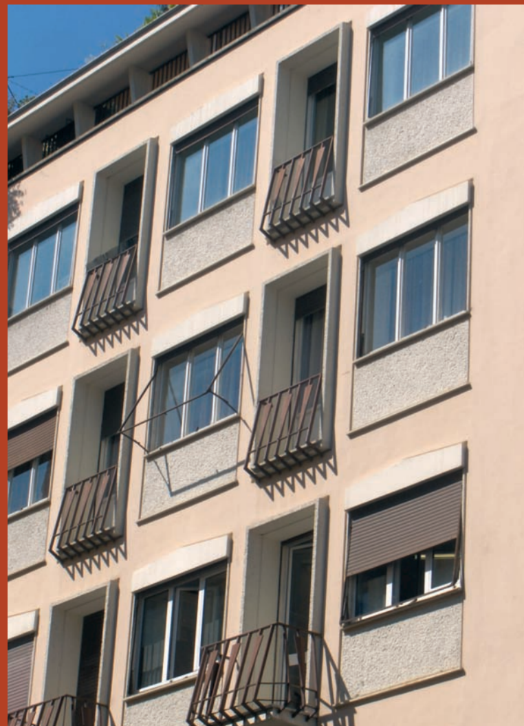
L. Vagnetti, «blocco Cacialli», fronte su Via Grande, particolare
