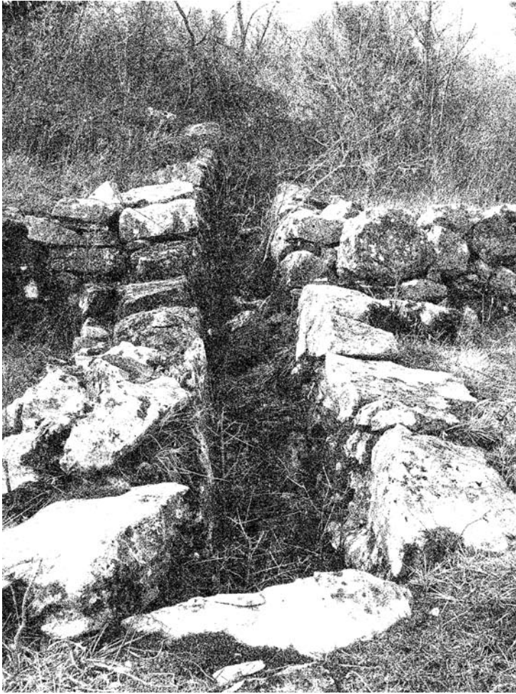
Sito della Bucaccia, canale adduttore al fosso omonimo: nella parte terminale il tratto è ipogeo
