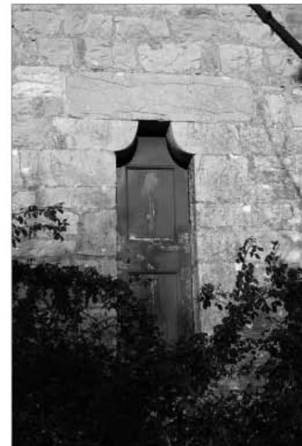
foto 1.4 portale laterale della chiesa
