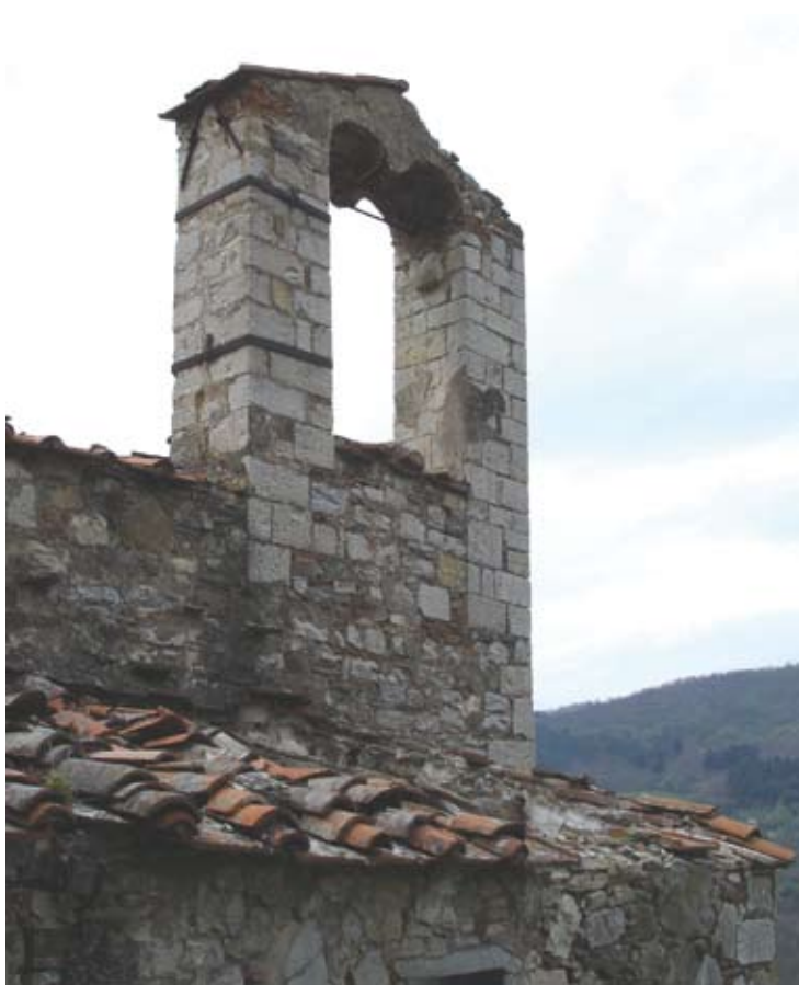
Vista da Nord del campanile a vela (Foto di M. Guasti, 2006)
