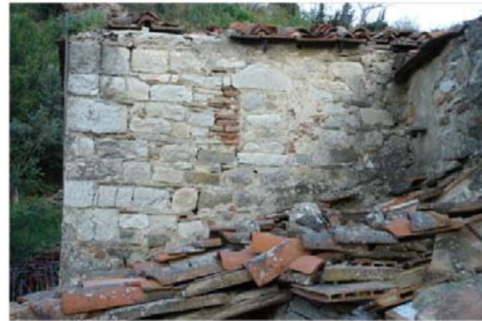
2. particolare di apertura tamponata con architrave monolitico in pietra alberese sagonata
