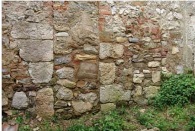
1. particolare dell'apertura tamponata
