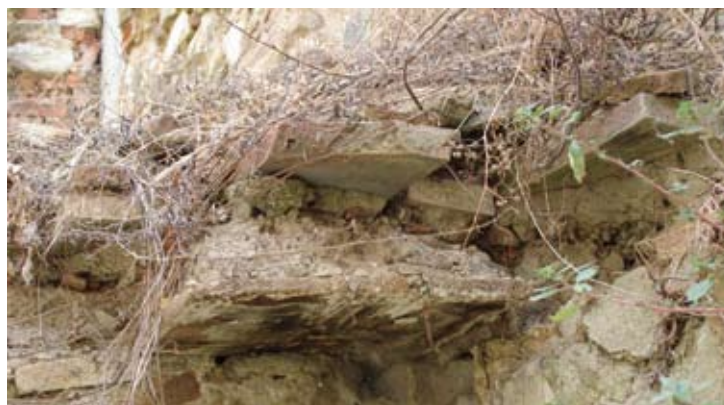
Particolari del solaio del piano primo, (in alto) quello presente nella parte della casa del contadino, (sopra) quello relativo all'ampliamento settecentesco (Foto di M. Guasti, 2006)
