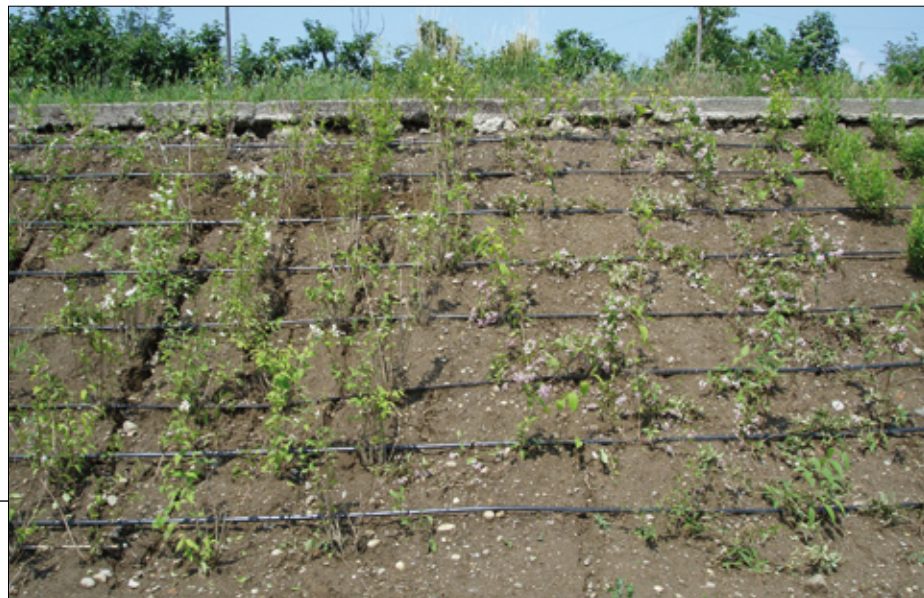
FOTO 1 – Danni da ruscellamento su terreno in pendenza, subito dopo l'impianto.
