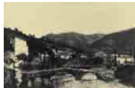
Figura 6 - immagine ponte Cerbaia (Guanci ma diritti di AFT) Figura 7 -
