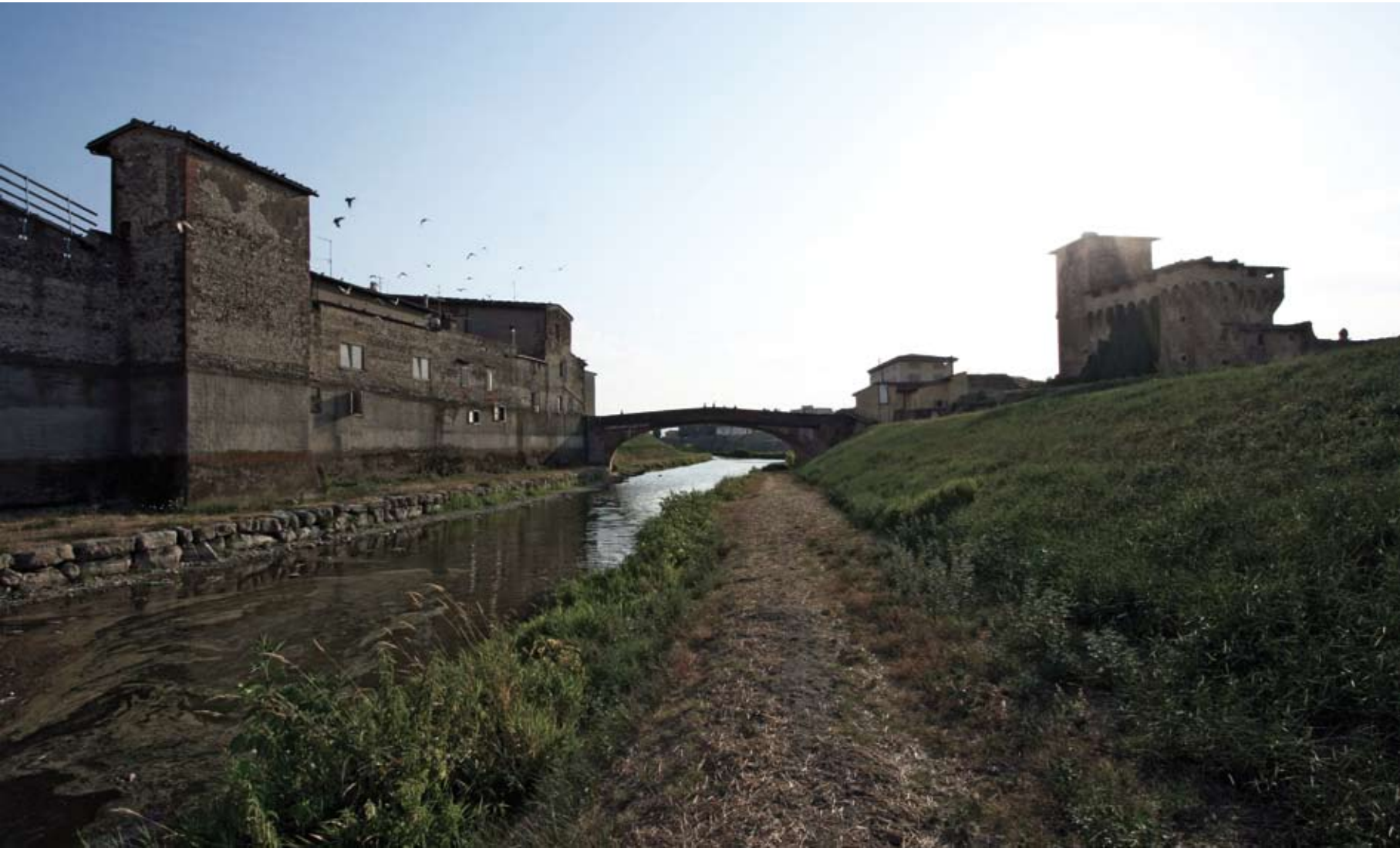
Figura 35 foto attuale ponte Campi (fotografo)
