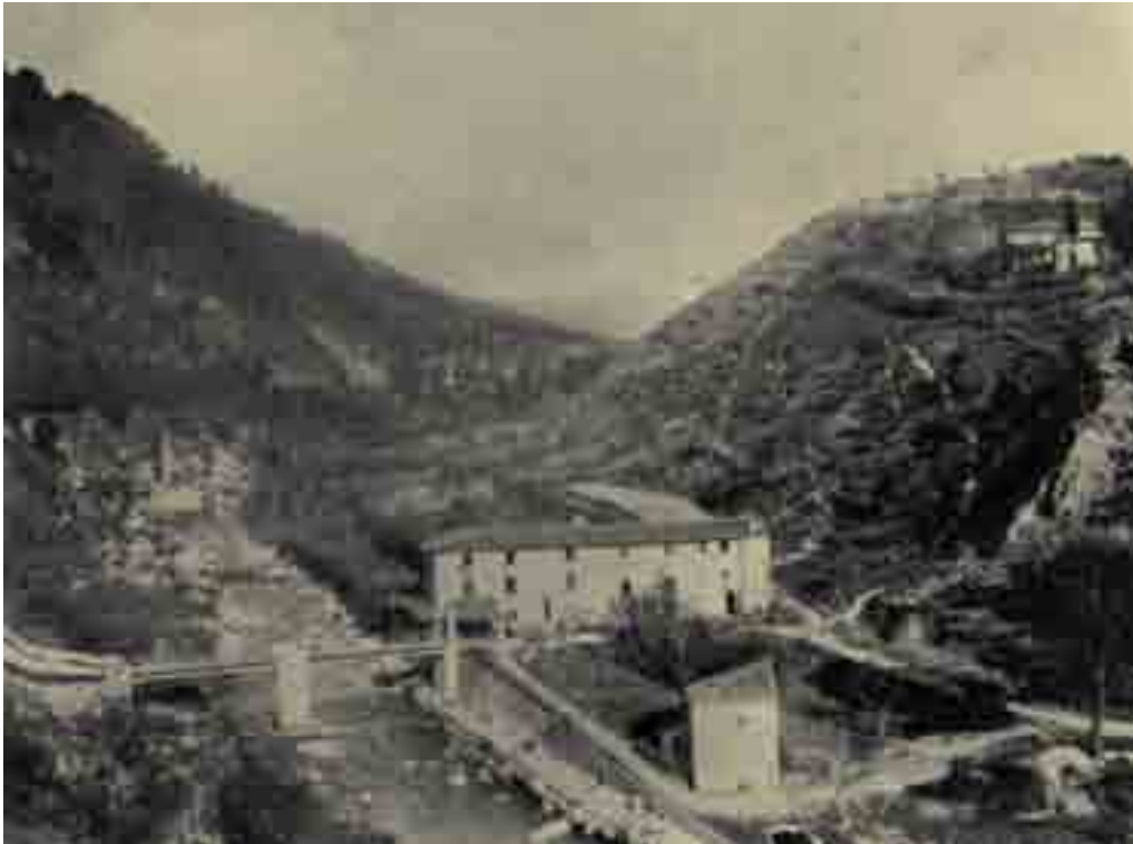
Figura 22 - foto storica Cartaia con ponte (Guanci ma diritti AFT)
