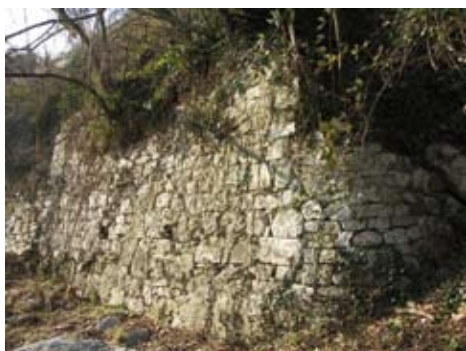
Figura 20 - foto spalla ponte Gamberame (Guanci)
