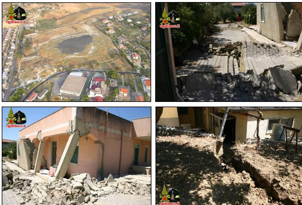
Fig. 119 - Foto dei dissesti alle abitazioni ed alle infrastrutture verificatesi l'11 Agosto 2008 nell'area dei Vulcanelli (da http://www.vigilfuoco.it/notiziario/notizia.asp?codnews=6780 ).
