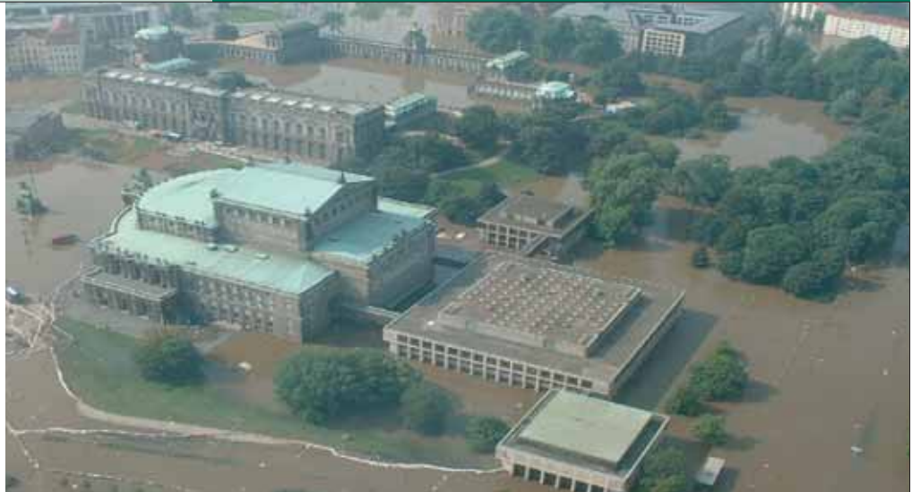
1: Dresda, l'edificio dell'Opera durante l'alluvione del 17 Agosto 2002.
