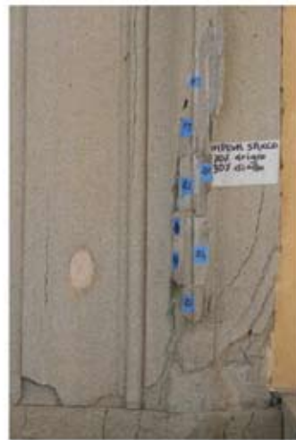
Consolidamento selettivo con stucco
