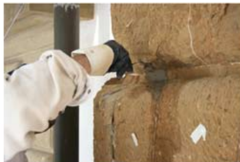
Preconsolidamento con applicazioni localizzate
