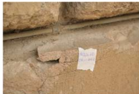
Consolidamento con resina epossidica
