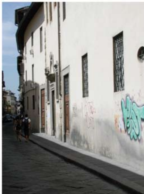
Fenomeni di degrado a carico dell'intonaco dipinto: umidità di risalita, perdita del colore e scritte graffite
