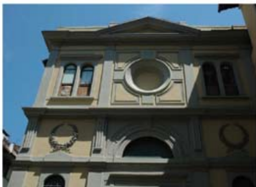
Tinte armoniche esemplificate sul fronte di facciata
