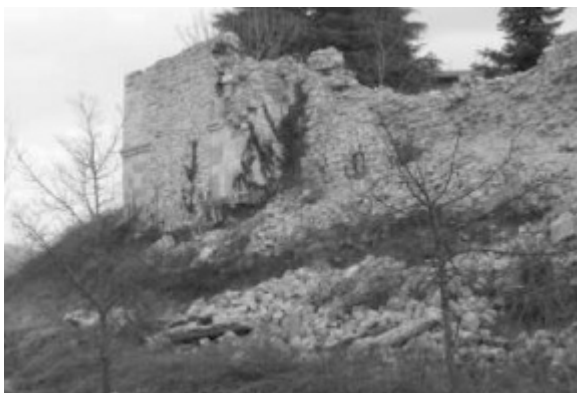
Le mura urbane dopo il terremoto dell'aprile 2009.
