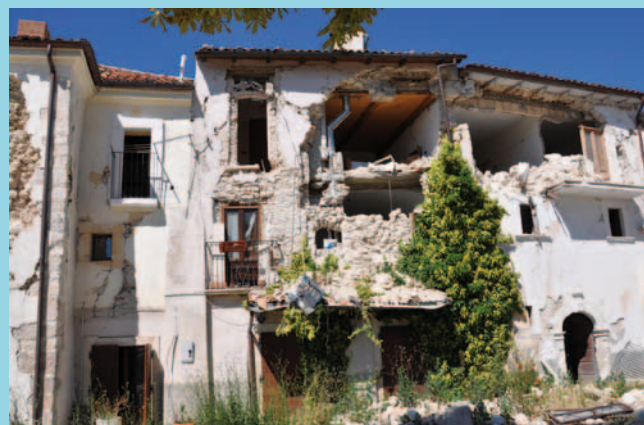
Terremoto del 6 aprile 2009. Castelnuovo delle Camere (AQ). Crollo per ribaltamento di facciata.
