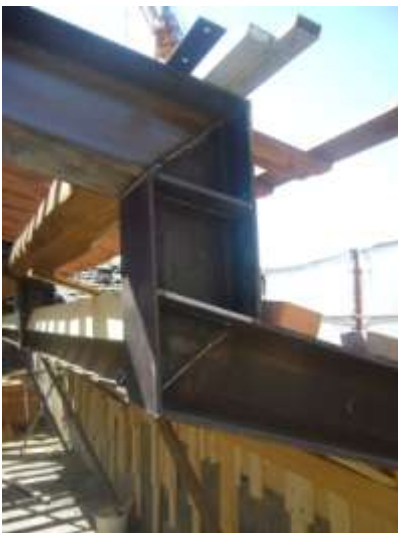
Particolare della trave principale in acciaio della copertura
