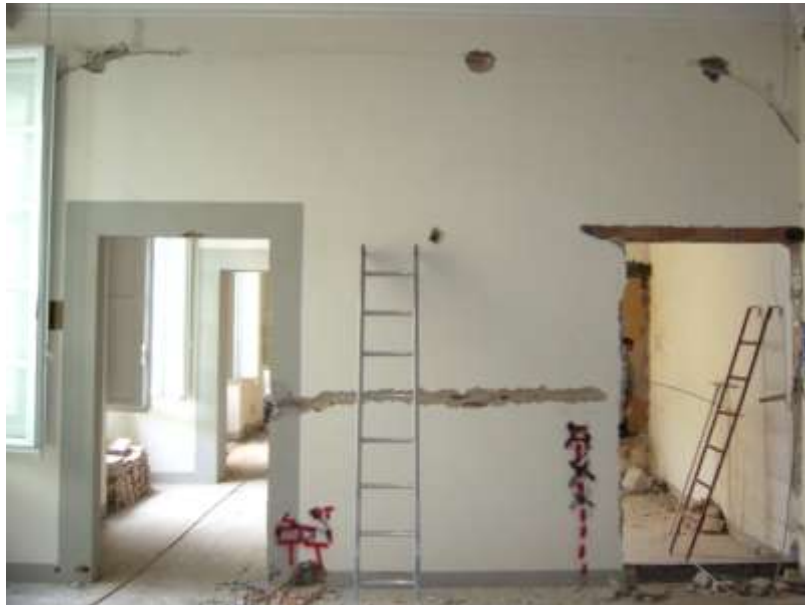
Parete di tamponamento esistente
