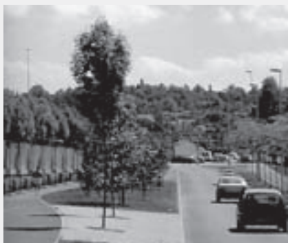
Il Bip (Boulevard intercommunal du Parisis), che attraversa la banlieu a nord di Parigi, è un esempio di autostrada urbana con sezione trasversale e trattamento dei margini continuamente variabili in funzione del disegno urbano e della qualificazione paesaggistica delle aree al contorno (P. Duguet, 2002-2007).
