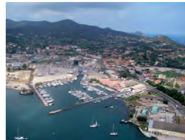
Fig. 8. Il porto cantieri, un'area industriale da riqualificare e rigenerare
