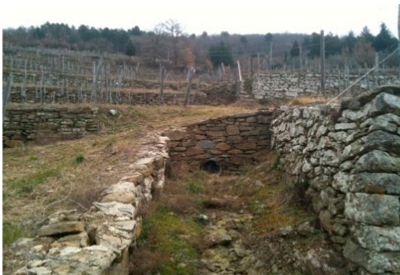
Figura 1. Canale di raccolta delle acque di drenaggio ("acquadoccia").
