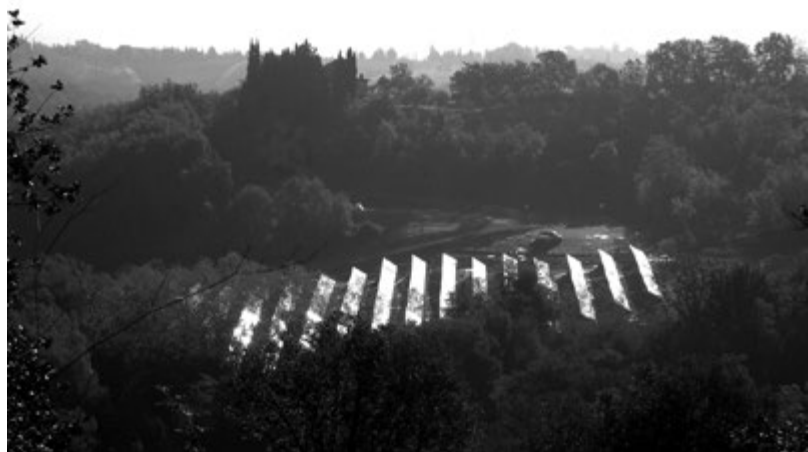
Figura 9. Impianto fotovoltaico di un megawatt nei pressi della località Pino (Tavarnelle Val di Pesa).
