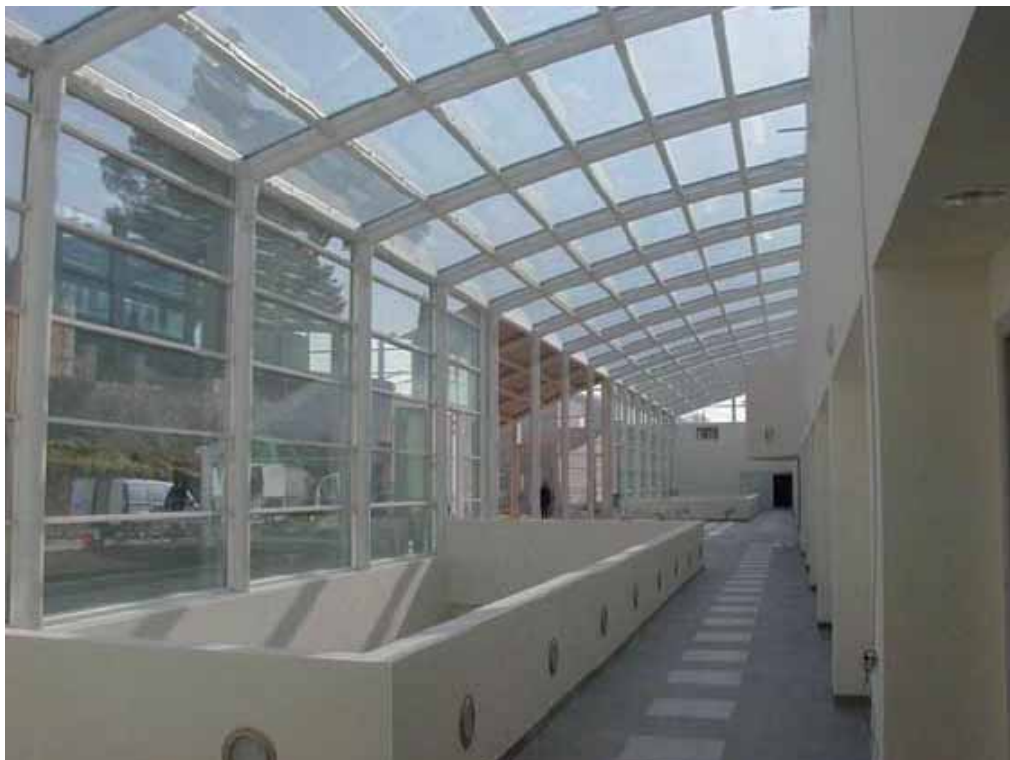
Fig. 3.46 Grandi superfici vetrate per la distribuzione della luce naturale.
