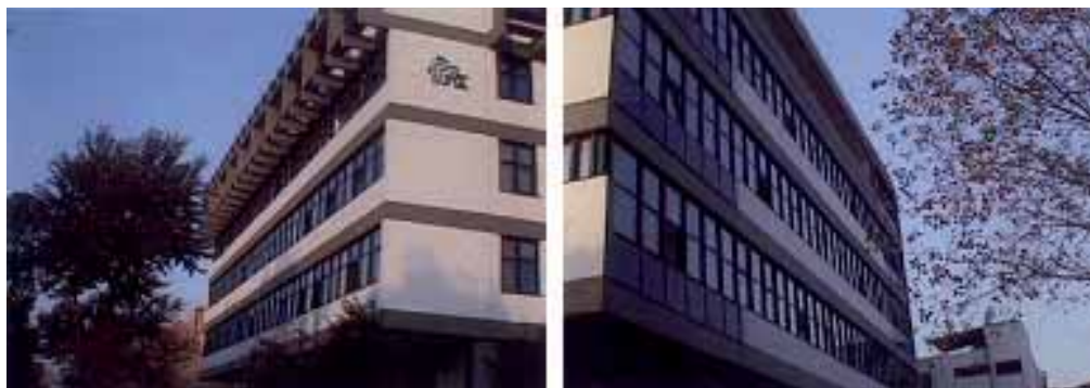
La facciate a sud-est e nord-ovest prima dell'inserimento di schermature.
