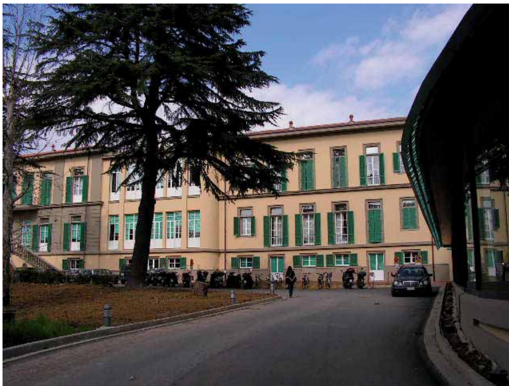
La facciata sud di Villa Ognissanti.
