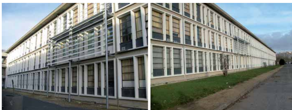
La facciata durante il montaggio delle schermature solari.
