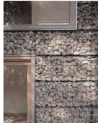
Costruzione a secco in pietra.
