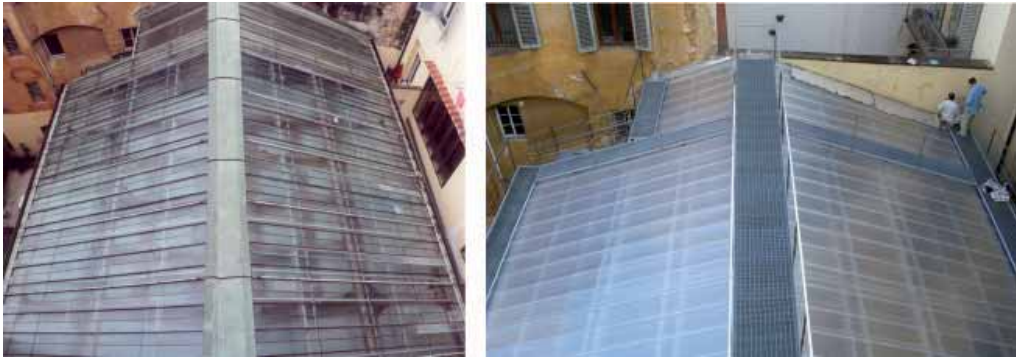
La copertura della sala centrale. Prima e dopo l'intervento di recupero.
