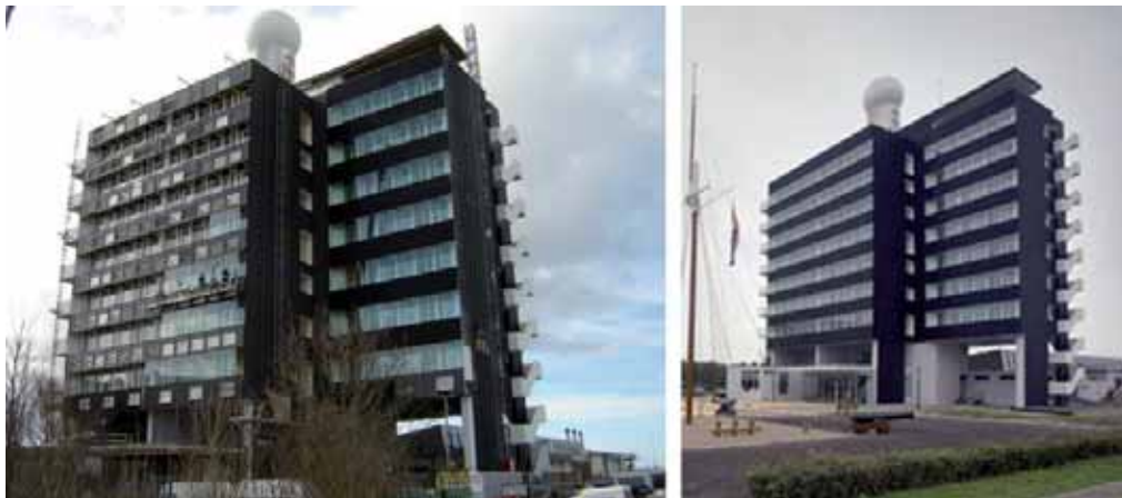
Le fasi di montaggio della double-skin.
