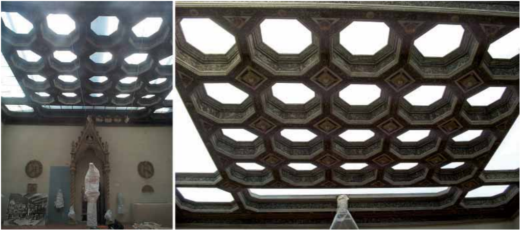
Il lucernario della sala centrale prima e dopo l'intervento.
