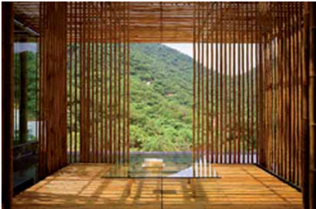
Edifici con pareti e pavimenti in bambù.
