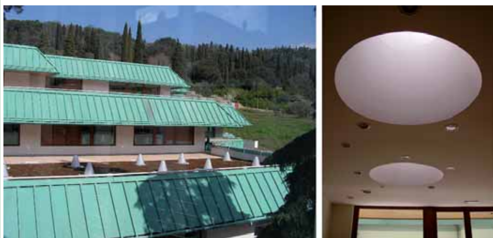
I condotti solari: le cupole sul tetto verde e i diffusori di luce all'interno dell'edificio.
