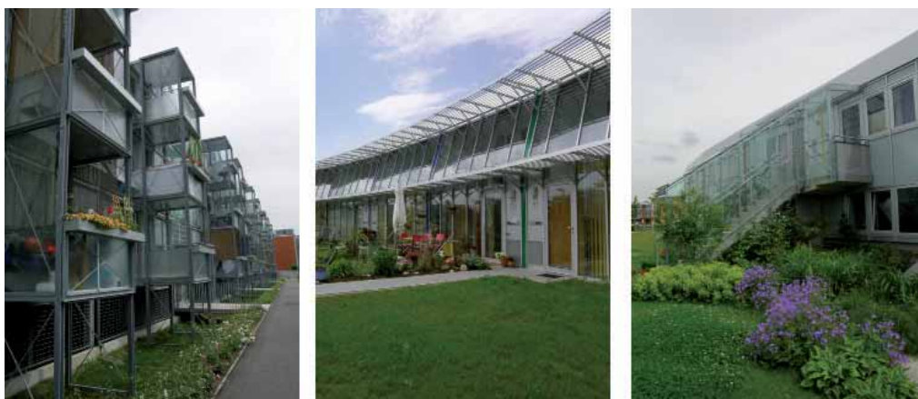
Fig. 3.5a – 3.5b – 3.5c Gli edifici del complesso residenziale Solar City Linz, Austria, 1996-2006, caratterizzati da un involucro iperisolato (Norman Foster, Richard Rogers, Thomas Herzog e Renzo Piano Building Workshop in qualità di consulente del gruppo progettuale).
