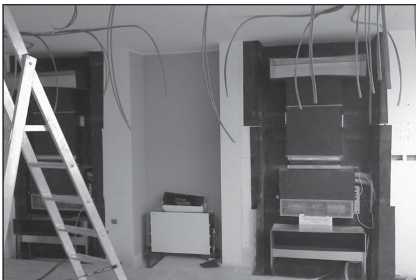
Fig. 4 – Avanzamento dei lavori, sostituzione fan coil
