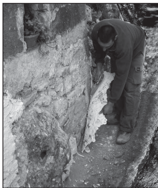
Fig. 9 - Rimozione dell’impacco di cellulosa modificata contenente i sali estratti.
