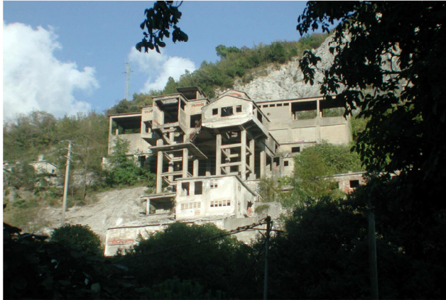
Figura 9. Lo stabilimento abbandonato "G. B. Tassara" a Torano, da riconvertire per attività culturali e di servizio.
