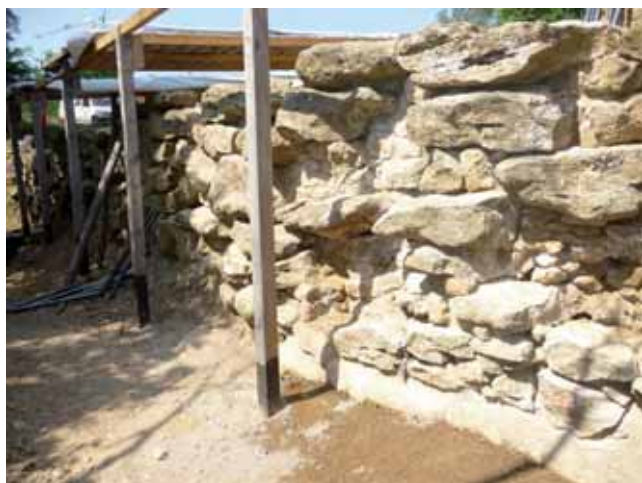
fig. 100 - Torricella: tratto di muro restaurato con reintegrazioni di rincalzo eseguiti sottosquadro.
