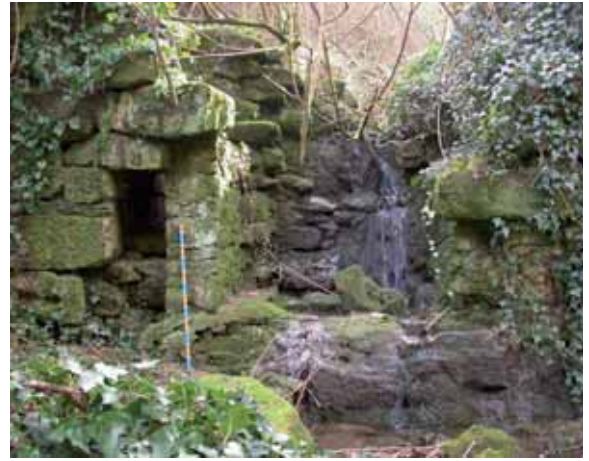
fig. 38 - Docciola: apertura di scolo.
