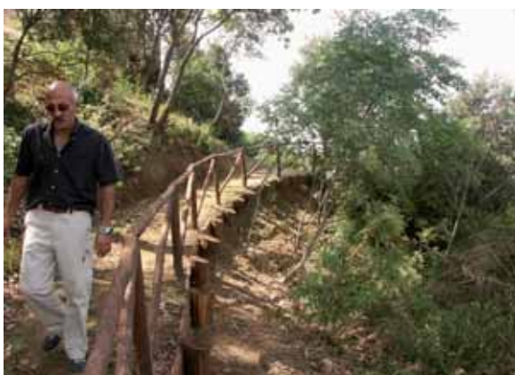
fig. 86 - Le Balze: particolare scavalco muro in legno.
