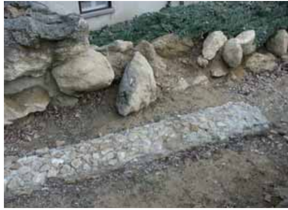
fig. - 71. Golfuccio – particolare setto di consolidamento del terreno eseguito negli anni '80.
