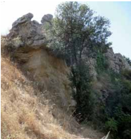
fig. 15 - Le Balze, intervento di ricalzo della struttura muraria.
