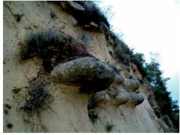
fig. 13 - S.P. 15 Volterrana nei pressi della Badia: potenti intercalazioni arenacee fortemente degradate nei Calcari di Volterra. L'erosione accelerata delle arenarie ha portato in evidenza livelli di roccia calcarea a minor grado di alterazione.
