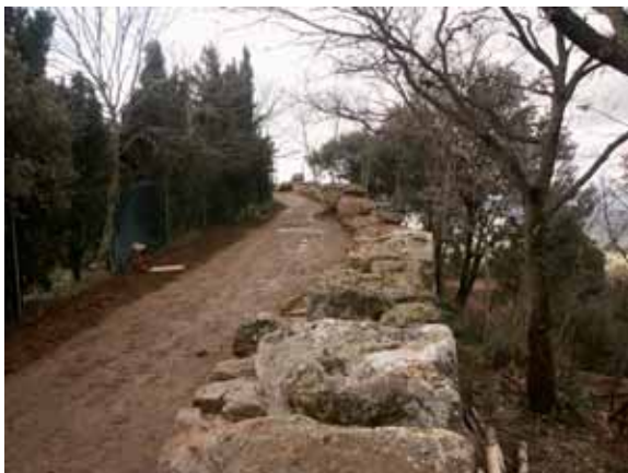
fig. 81 - Le Balze: sistemazione del piano di campagna interno.
