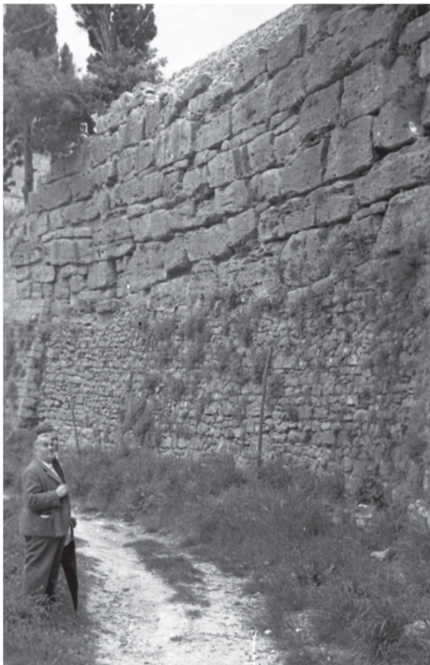
fig. 39 - Mura etrusche località Santa Chiara.
