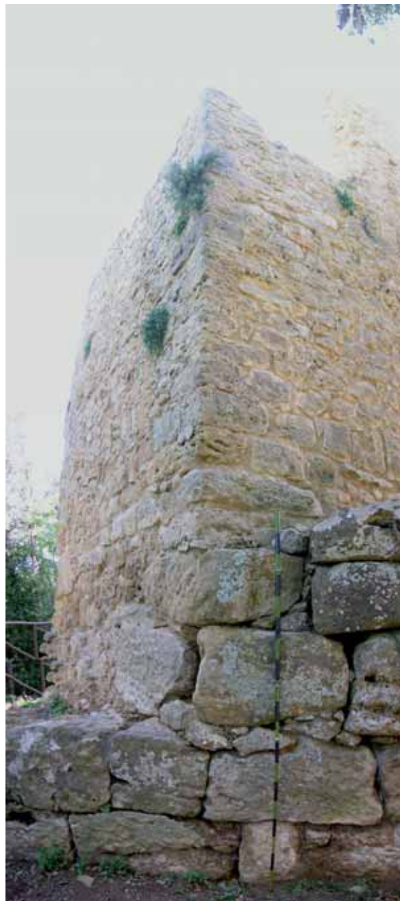
fig. 97 - Torricella : particolare innesto muro torre.
