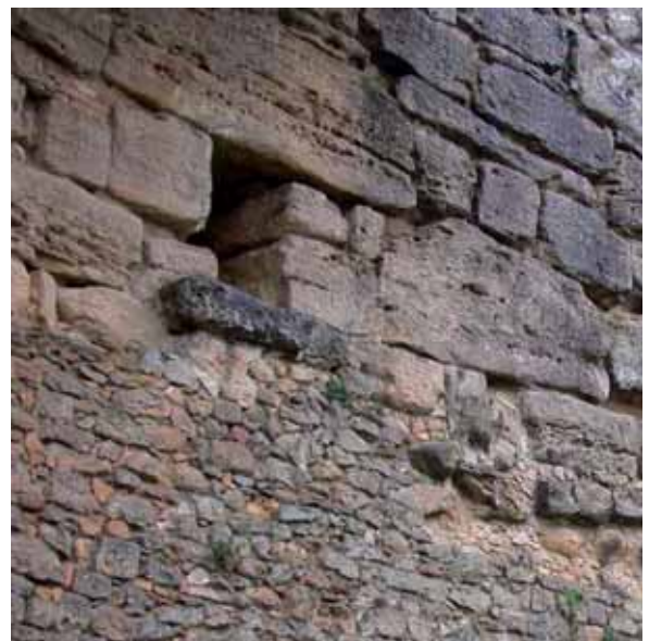
fig. 40 - Santa Chiara: bocchettone di scolo.
