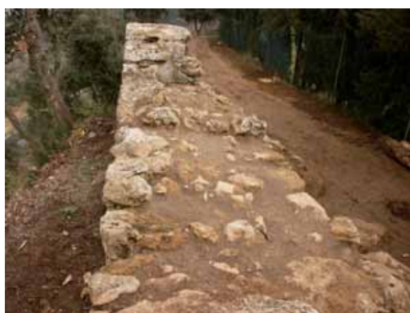
fig. 80 - Le Balze: particolare sistemazione delle creste del muro.
