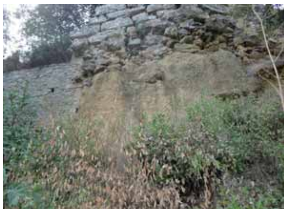
fig. 85 - Le Balze: particolare della ricostruzione della roccia artificiale.
