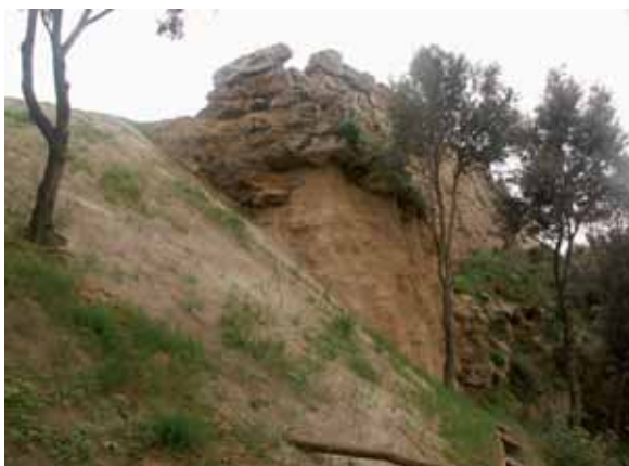
fig. 84 - Le Balze: particolare della ricostruzione della roccia artificiale
