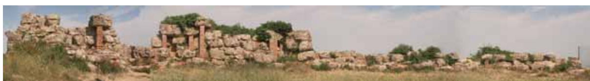
fig. 78 - Le Balze: tratto murario con gli interventi di consolidamento degli anni '80.
