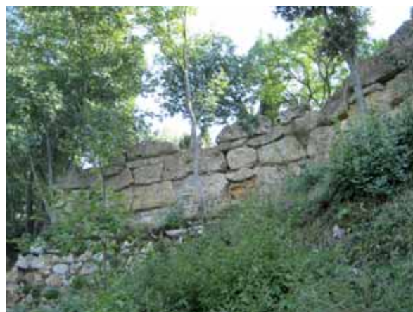
fig. 33 - Guerruccia: tratto di muro su lato esterno ovest.
