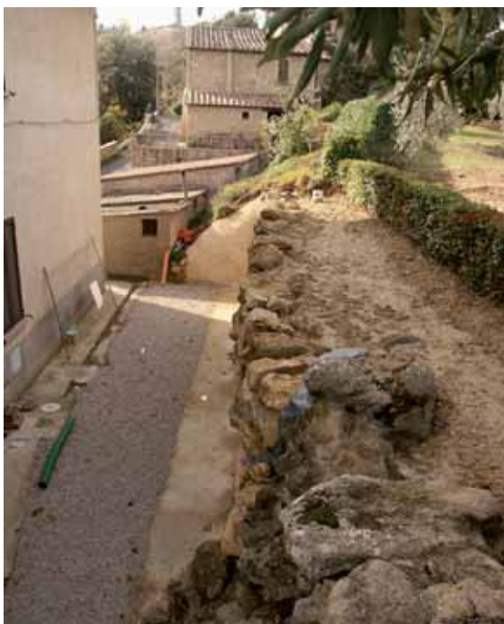
fig. 74 - Golfuccio – tratto murario in fase di rimontaggio.
