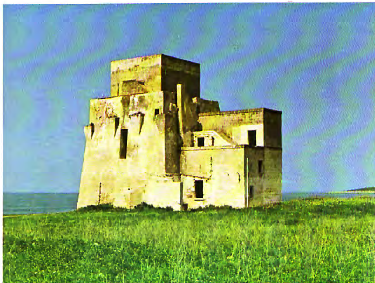
15. Torre Saturo. Veduta del lato sud-est (Foto I. Kariv).
