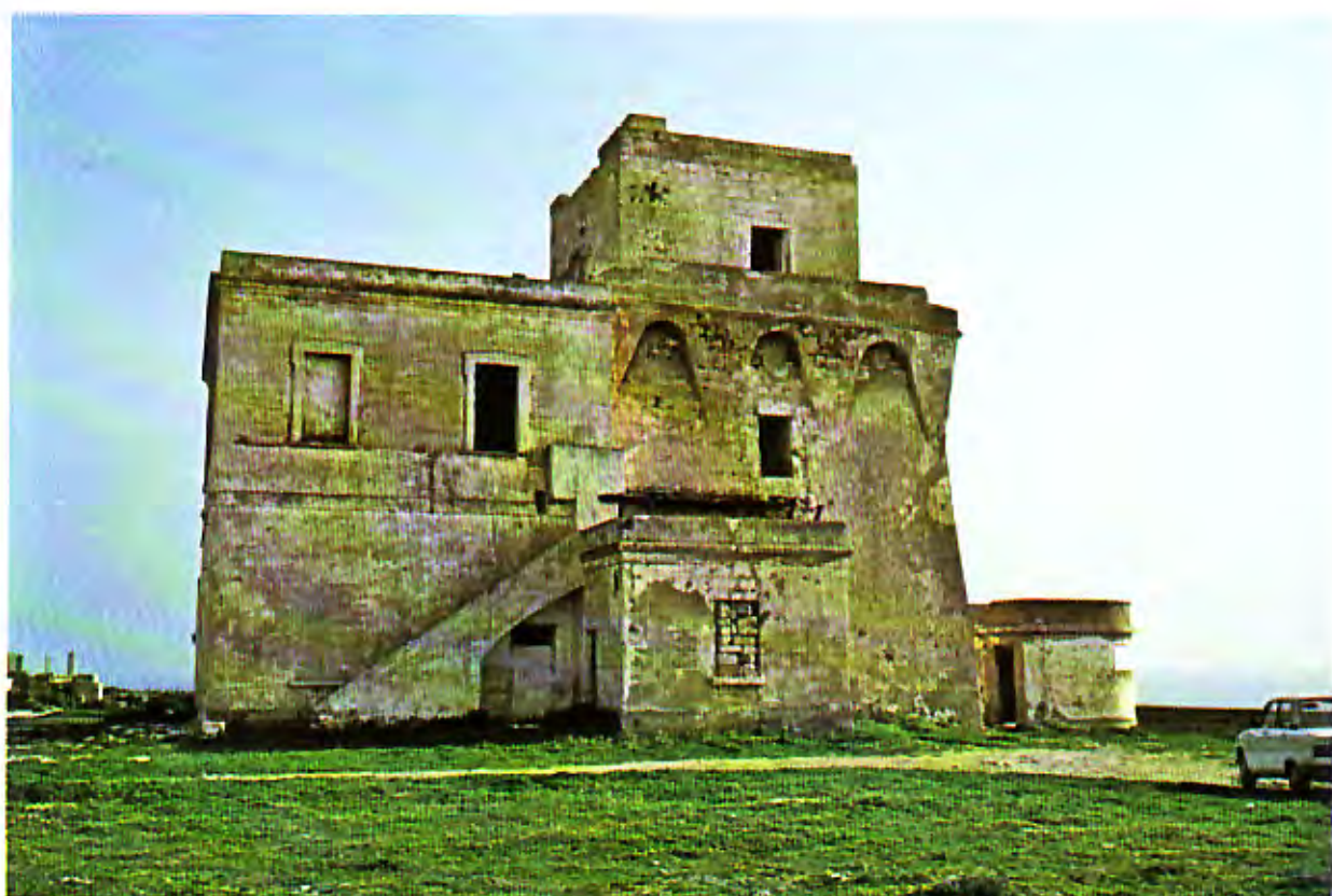
18. Torre dell'Ovo. Veduta del lato costa-ovest.
