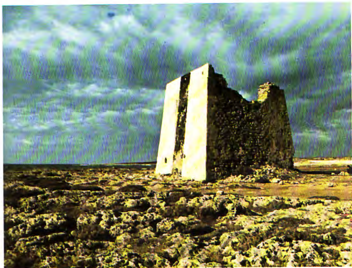
17. Torre Zozzoli. La torre ripresa da est.
