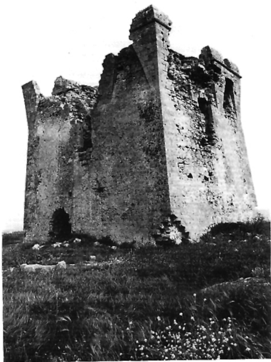
103. Torre Boraco. Esterno da nord-ovest. La parete a monte ha la parte superiore completamente crollata.
