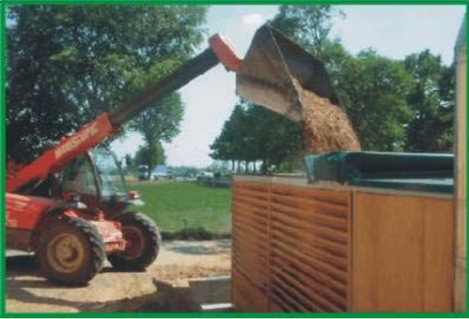
Modalità di riempimento del silo di stoccaggio
