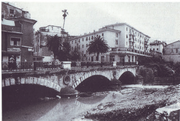
19. Ponte sul Carione alla Lugnola. Stato attuale. Bridge on Carione at Lugnola. Present condition.
