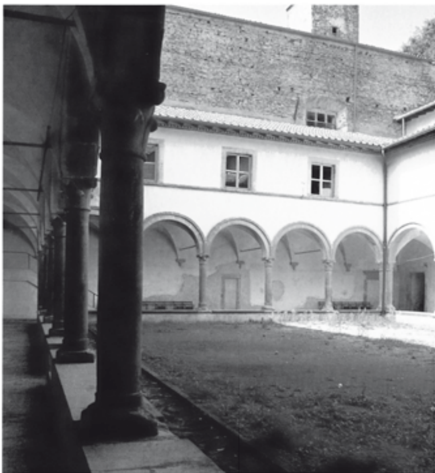
Pontremoli, santuario della Santissima Annunziata, il chiostro.
