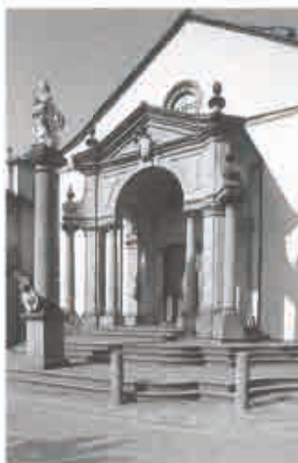
Pontremoli. Chiesa di San Francesco
