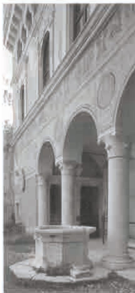
Missa, castello Malaspina: a destra, il castello interno; sopra, un particolare del loggiate superiore.
