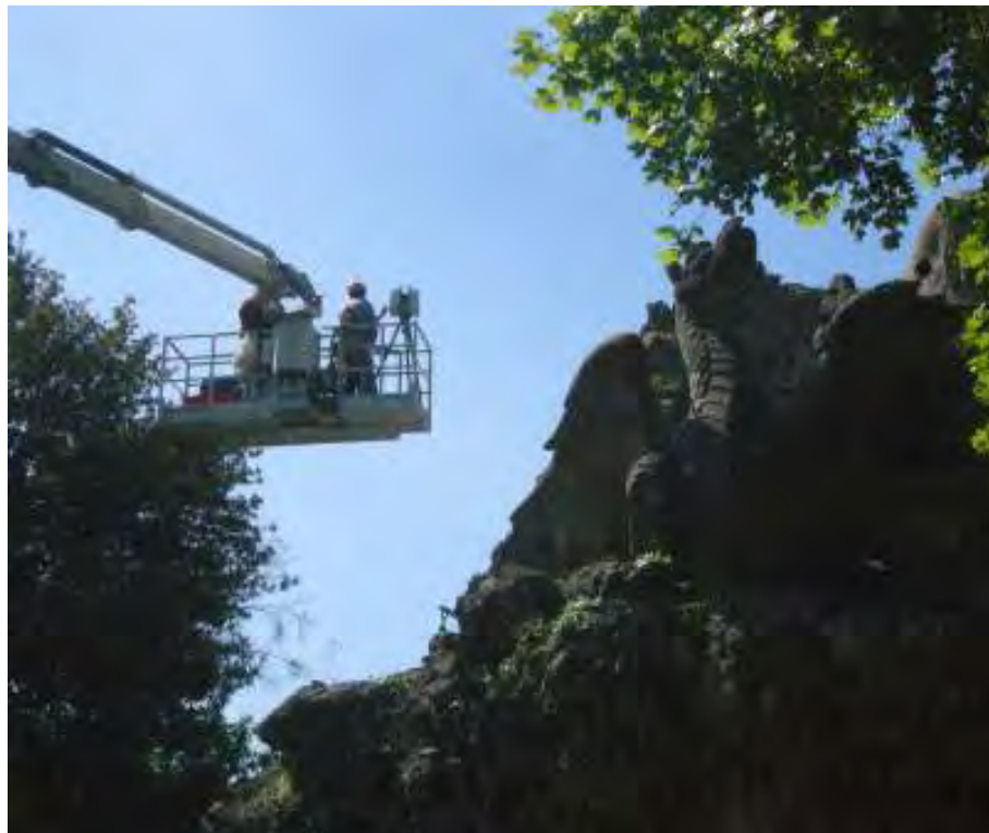
Fig. 59 - Scansione realizzata da cestello elevatore (Gigante dell'Appennino, Parco Mediceo di Pratolino, Firenze, rilievo GeCo, 2011)
