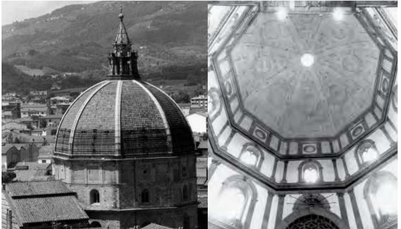
Fig. 77 - Aula vitoniana e cupola vasariana. A sinistra, vista esterna; a destra, vista interna. E' evidente l'imponenza della cupola all'interno del fitto tessuto edilizio urbano
