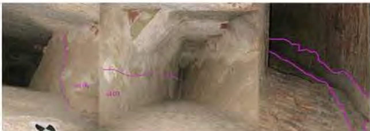
Fig. 137 - Secondo gruppo di lesioni: a sinistra e al centro, lesioni sui costoloni mediani e della lanterna; a destra, lesioni tra costoloni angolari e calotte
