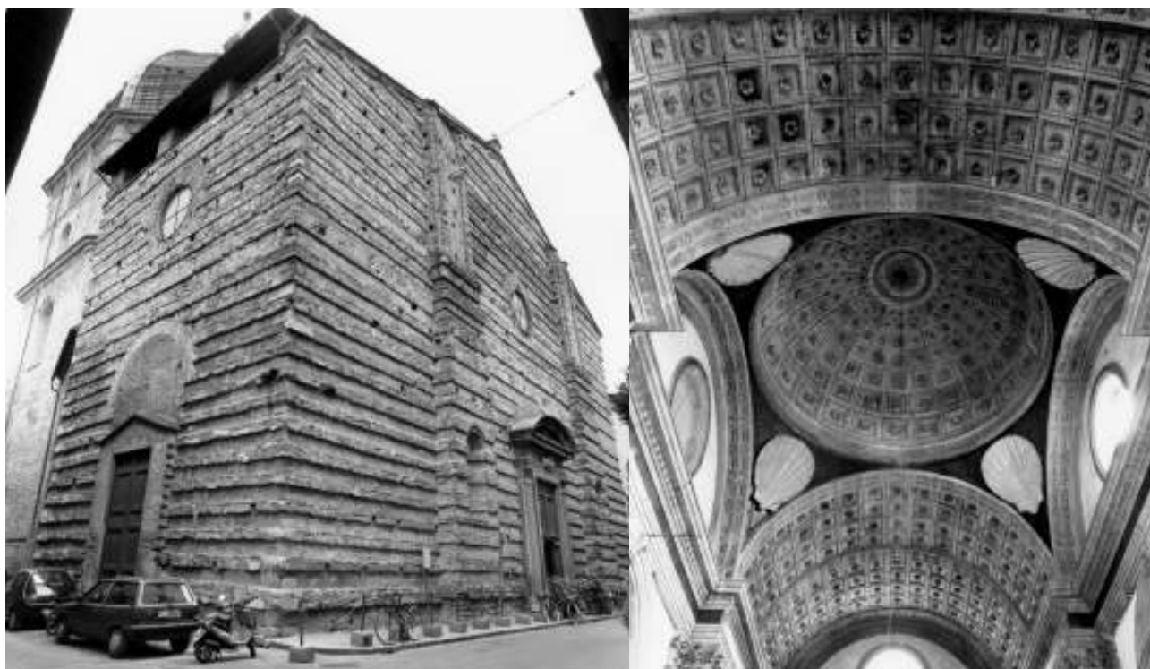
Fig. 76 - Vestibolo sangallesco. A sinistra, i prospetti su via della Madonna e via Vitoni; a destra, vista del cupolino e delle volte a botte
