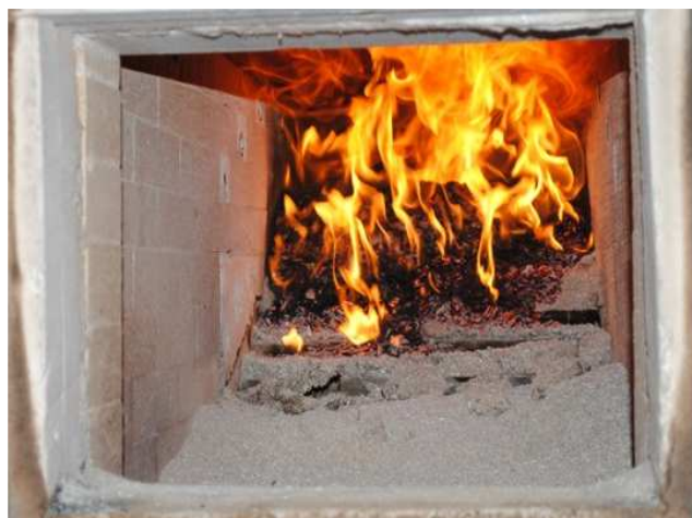
Foto 5. Dettaglio della camera di combustione.
