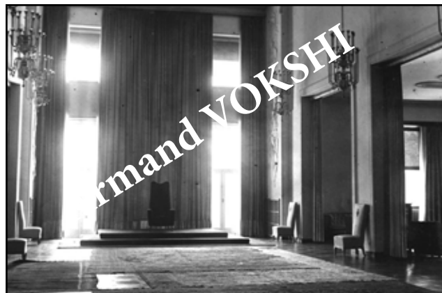
144. G. Bosio, Villa Luogotenenziale (ex Villa Reale), Tirana, 1939-41, foto della sala principale (Pelago, Archivio eredi Gherardo Bosio)
