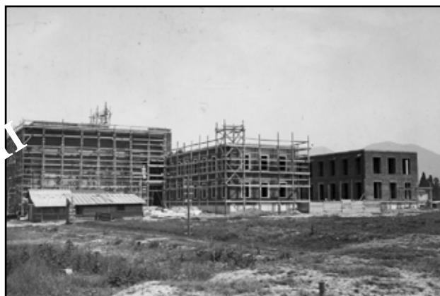
125. G. Bosio, Uffici Luogotenenziali, Tirana, 1939-41, foto d'epoca durante i lavori (Pelago, Archivio eredi Gherardo Bosio)
