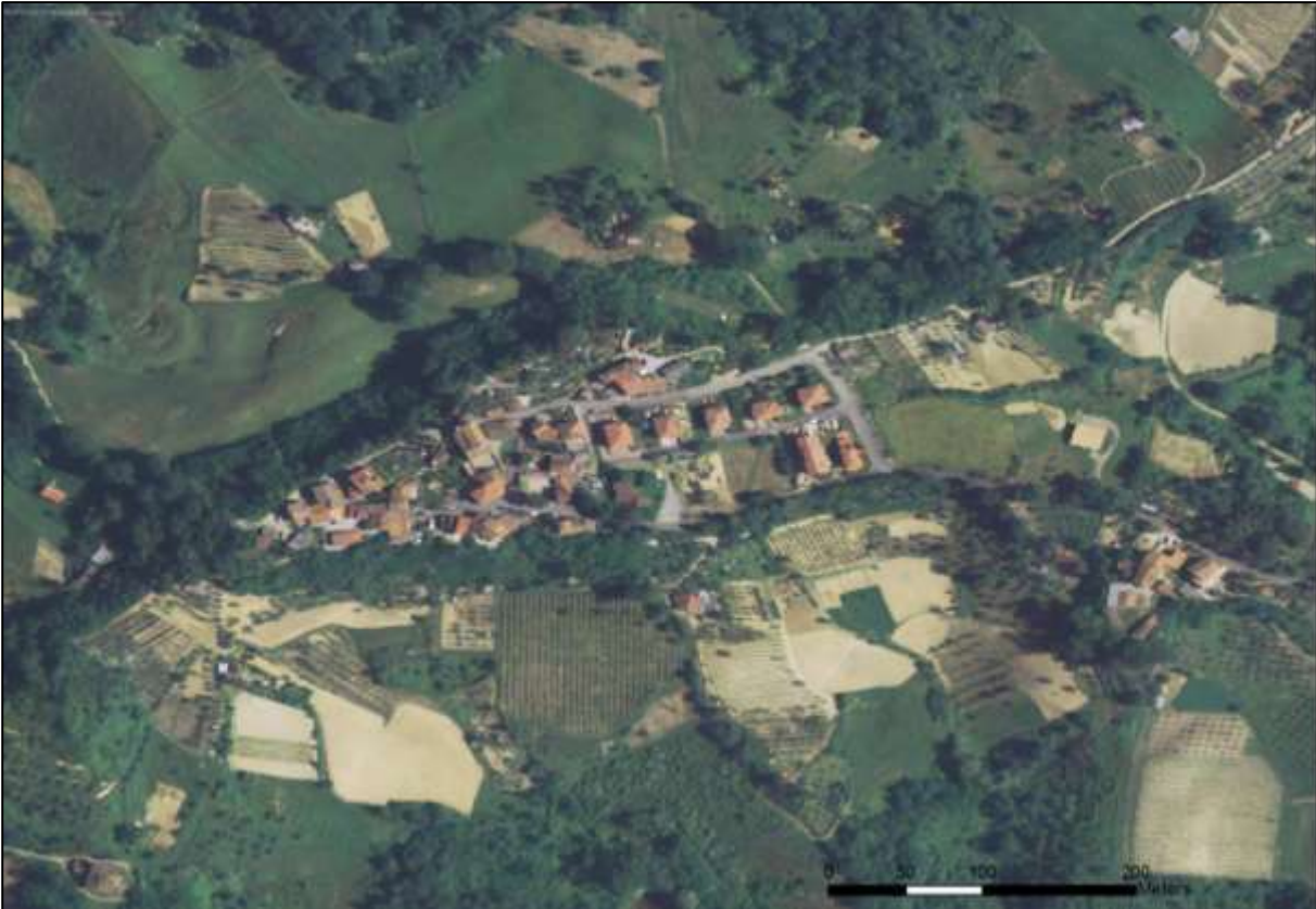
Figura 12 Foto aerea dell'abitato di Ricasoli. Si riconoscono le deformazioni del terreno indotte dai fenomeni franosi nel versante settentrionale del paese.
