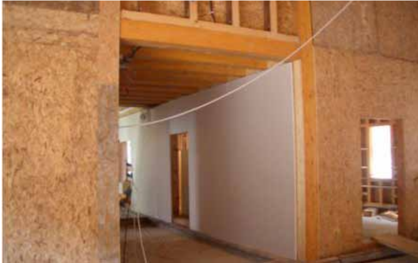
Pic. 12 -Scuola primaria e dell'infanzia, Fabbriche di Vallico (Lucca)
