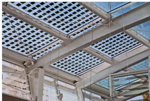
Fig. 25.13 Particolare copertura della serra in fotovoltaico semitrasparente.
