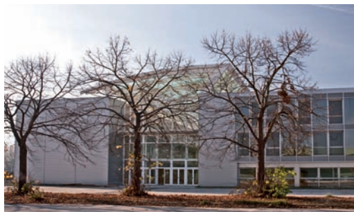
Fig. 25.4 Ingresso fronte est.
