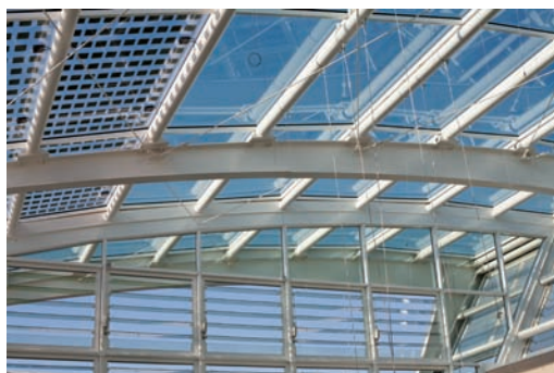
Fig. 25.11 Serra, particolare della copertura.
