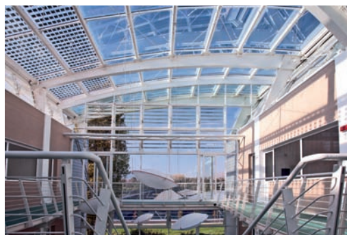
Fig. 25.14 Serra. Vista interna verso ovest.
