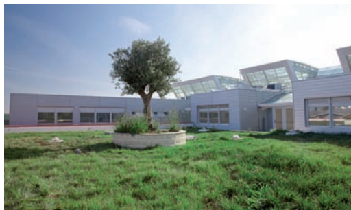
Fig. 25.3 Tetto giardino dei laboratori.
