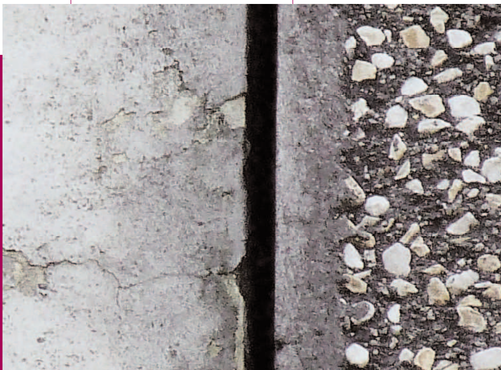
Figura 18. Il giunto tra chiesa e campanile.
