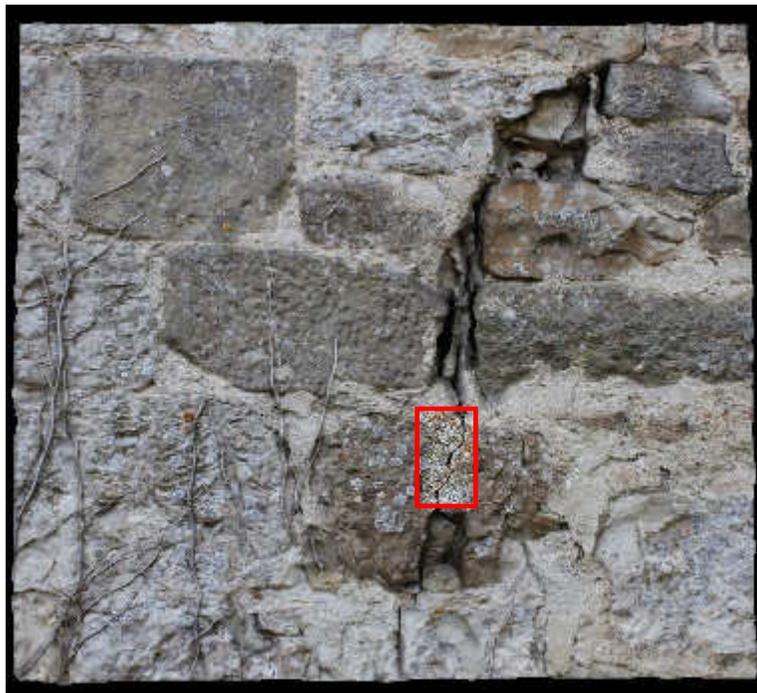
*Figura 38: il modello 3D dell'area della lesione, realizzato con l'obiettivo 28mm, con la sovrapposizione dei modelli realizzati con l'obiettivo macro*
