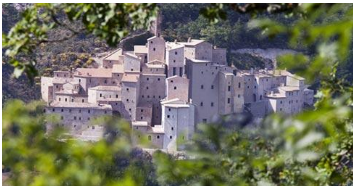
Fig. 10. Il Borgo di Postignano in Umbria "archetipo dei borghi collinari italiani" è stato integralmente ricostruito dopo l'abbandono ed i crolli provocati dal terremoto del 1997.
