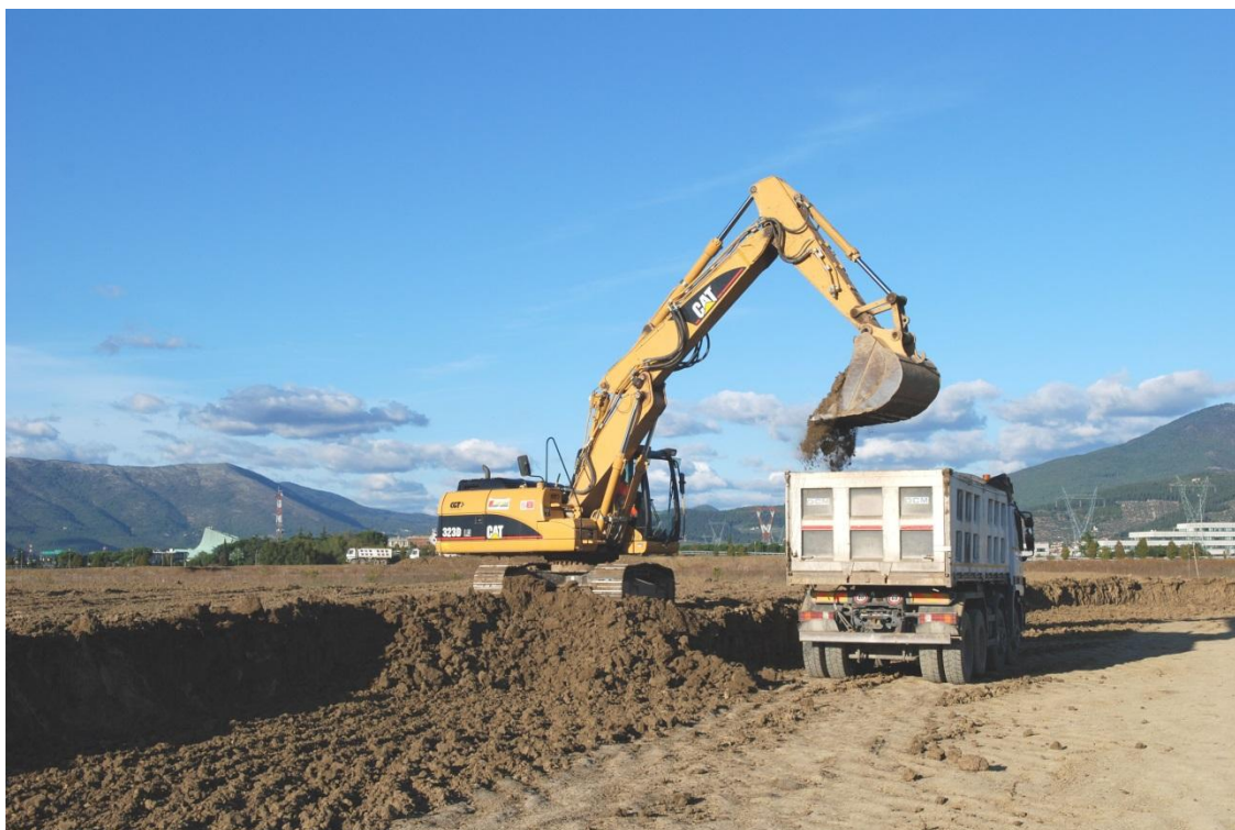
Fig. 2 Lavori in corso per un nuovo bacino lacustre _ sullo sfondo a sinistra la Chiesa dell'Autostrada di Michelucci.
