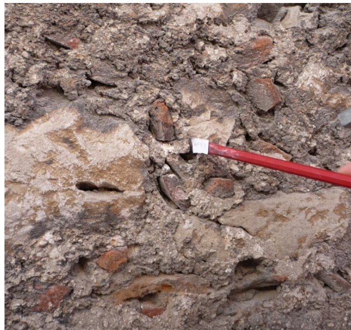
Fig. 23 - Campionamento dei materiali, fasi di lavoro (attività diagnostica preliminare al restauro)
