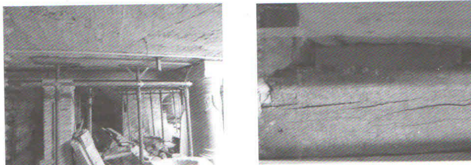
Figura 6. Dettaglio fotografico dell'architettura realizzata mediante coppie di putrelle e della trave di legno
