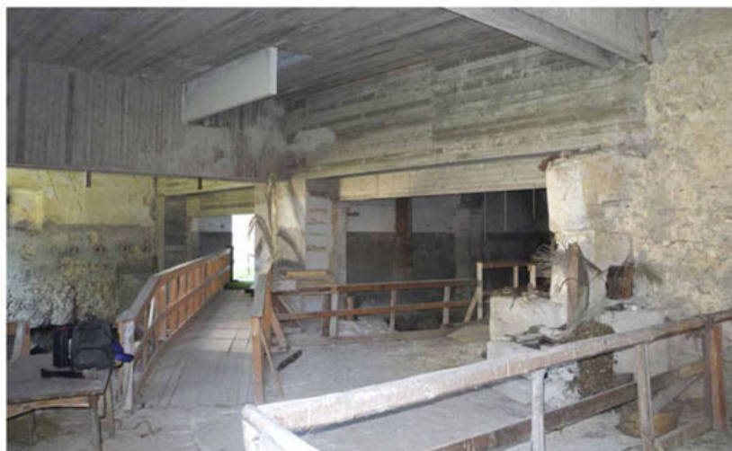
Fig. 11 Vista del piano terra, i nuovi solai e le travi ricalate in cemento armato a doppia ala che appoggiano (a destra) sui resti del sepolcro
