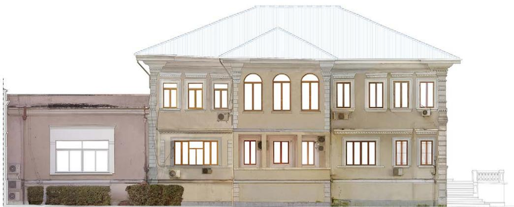
riore, mentre già nel 1931 le bucatore del piano terra fossero accorpate in lunghi finestroni (fig. 8). Dalle medesime testimonianze è possibile evincere come il bovindo del primo piano fosse in origine sorretto da mensole e soltanto in seguito sia stata introdotta la loggetta al livello inferiore che attualmente caratterizza il fronte.
