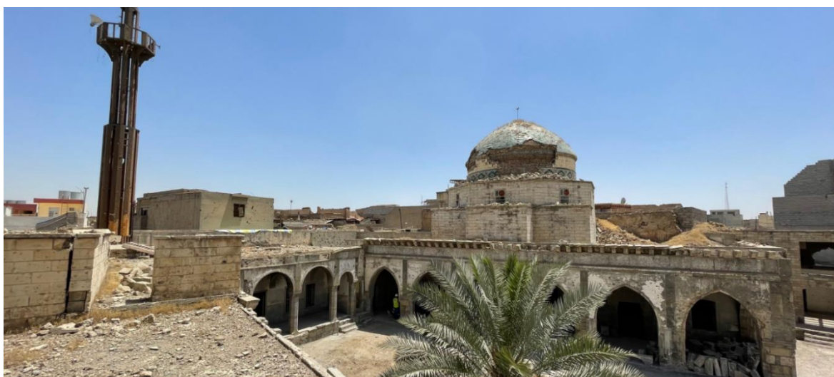
Figura 1. Veduta dello stato della Moschea a inizio lavori di rilievo
