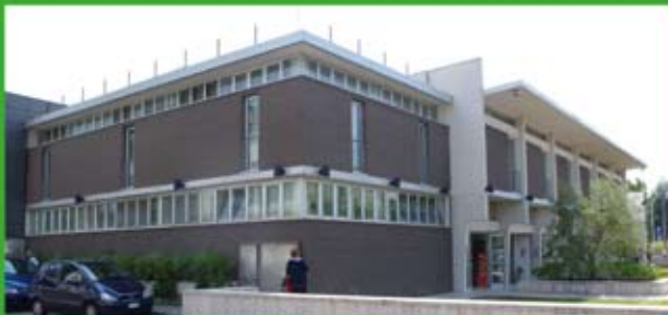
Veduta angolare dopo la ristrutturazione.
