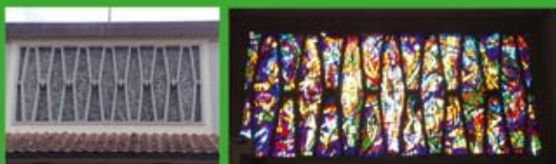
Particolare della facciata: il mosaico di vetro e litoceramica.
