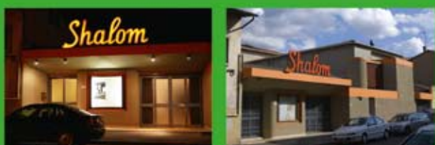
Vedute della facciata principale dopo il recente 'restyling' cromatico.
