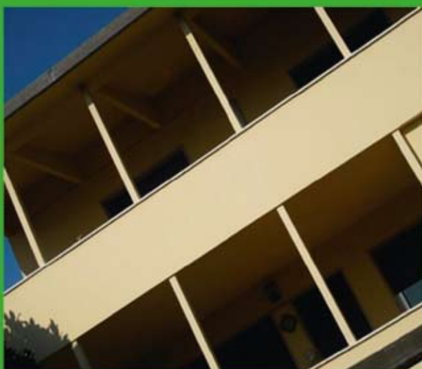
Veduta del porticato anteriore.
