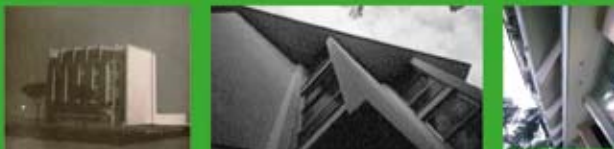
La facciata prima e dopo l'intervento di ristrutturazione.
