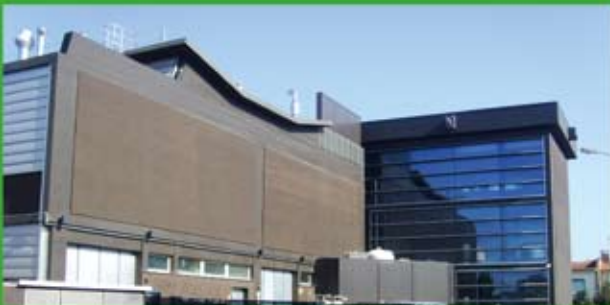
Vista del fianco meridionale.
