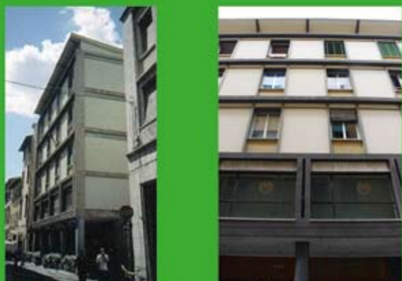
Prima della recente ristrutturazione. Il procedere dei piani verso l'alto.
