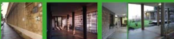
Il ritmo alternato cemento/pietra. I percorsi interni nobilitati dai pilotis.
