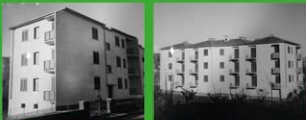
Foto d'epoca delle stecche della seconda fase (1954) appena realizzate.
