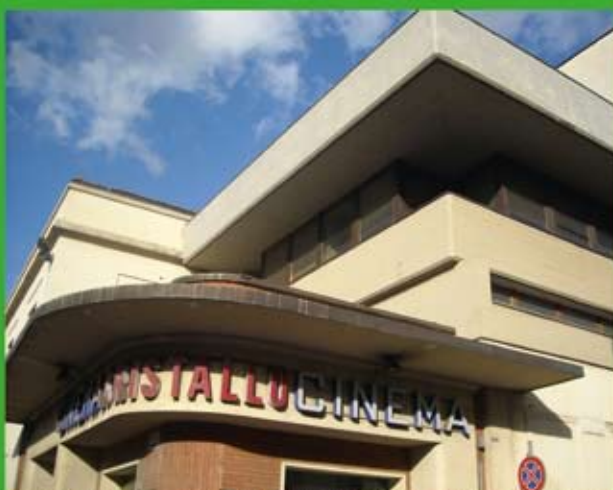
Particolare della copertura del cinema Cristallo, col nuovo ampliamento.
