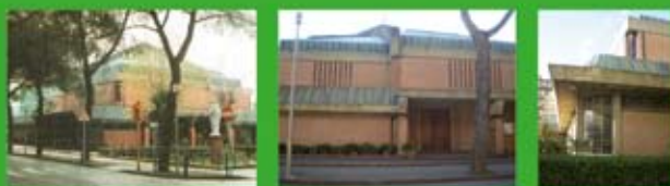
Vedute d'insieme, dell'ingresso e di uno spigolo.
