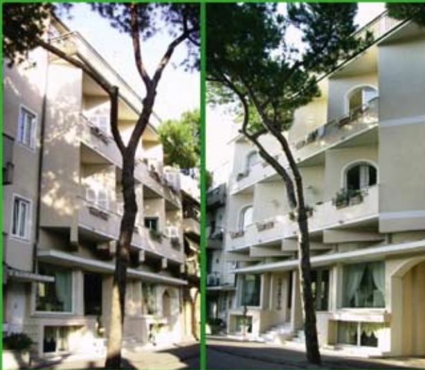
La facciata vista da Ovest e da Est.
