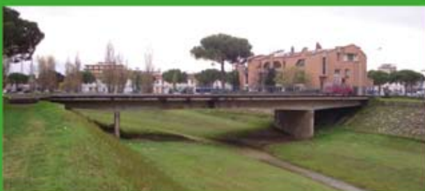
Vista del ponte.
