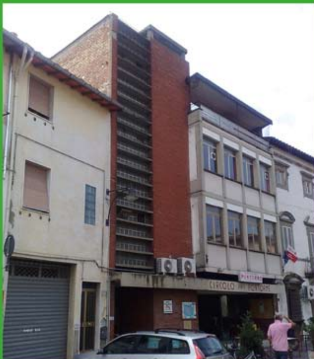
Veduta della facciata, col gioco di pieni e vuoti segnato dai materiali.
