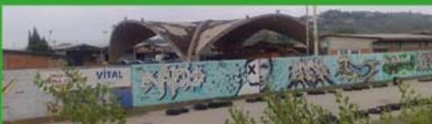
La struttura svetta dalla recinzione.
