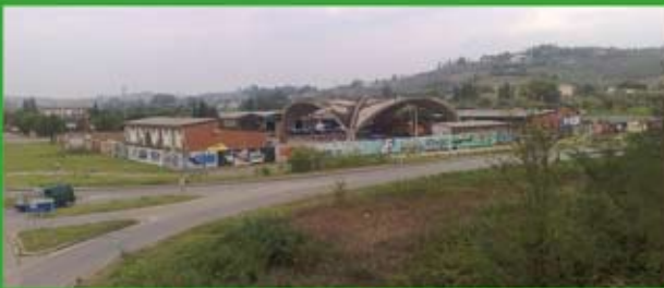
Veduta del complesso dal cavalcavia.
