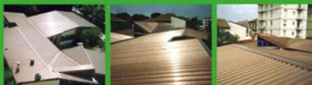
Viste dell'andamento mosso delle falde della copertura (oggi in rame).
