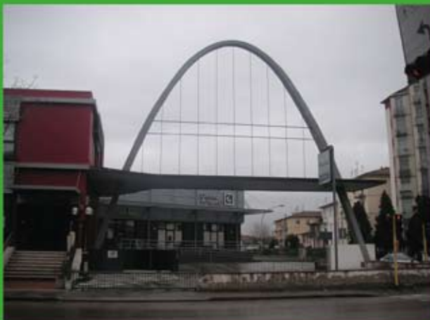
L'arco parabolico in cemento armato precompresso.
