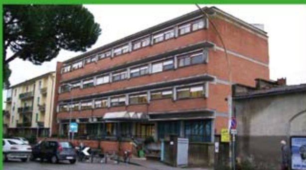
Il fronte su via di Rozzalupi.
