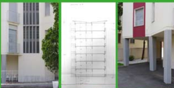
Le lame per le luci. Il coronamento obliquo. I pilastri a sezione variabile.
