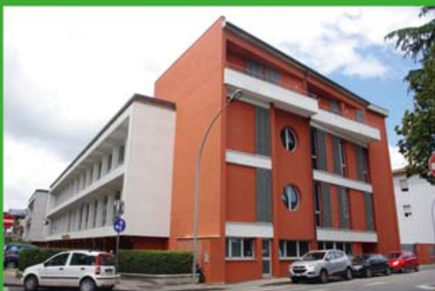
La soluzione angolare dopo la ristrutturazione.
