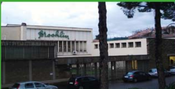
Il fronte principale verso la ferrovia il vuoto del cortile invita all'ingresso.
