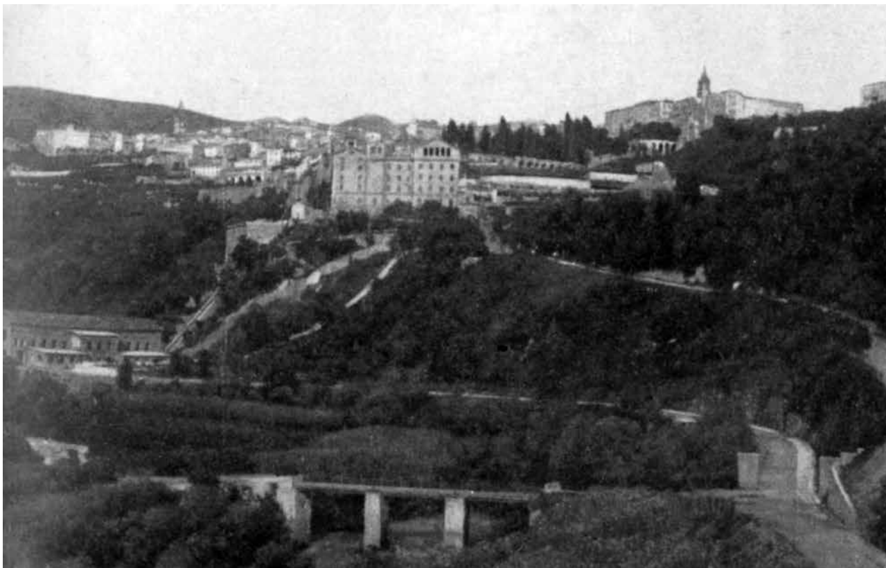
1. Veduta della zona dell'Acquoria in una foto precedente all'ampliamento della centrale: in primo piano il ponte moderno, contiguo a quello antico, a sinistra la vecchia centrale e, in alto, l'edificio della Pantanella (da MEZZETTI, L'Aniene, fonte di luce ... cit. )
