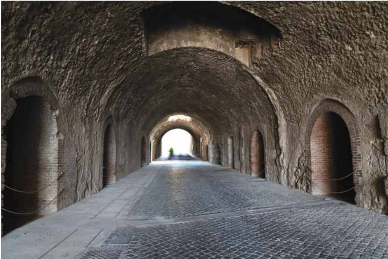
2. Tivoli, Santuario di Ercole Vincitore, La via Tecta, tratto coperto della via Tiburtina Valeria, vista da ovest (fotografia, Istituto Villa Adriana e Villa d'Este, 2018)
