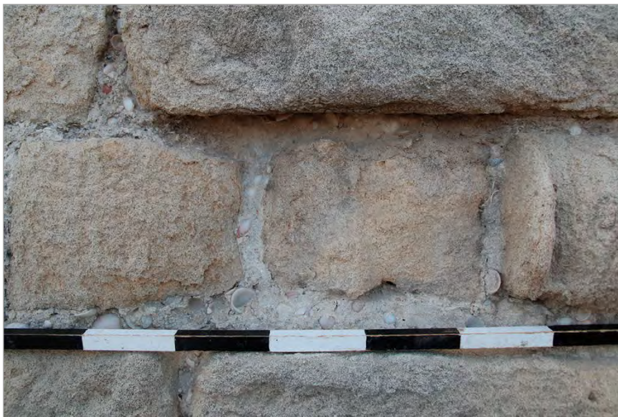
Fig. 17. Dettaglio della malta di calce, particolare dell'USM 100 = 107 (© AskGate).
