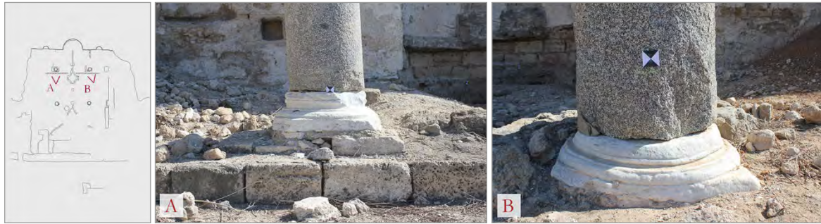
Fig. 7. Particolare delle basi delle colonne per come si presentano rispetto al piano di calpestio (© AskGate).
