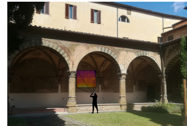
Fig. 4.7 acquisizione termogrammi durante le fasi di rilievo termografico, lato Ovest.
