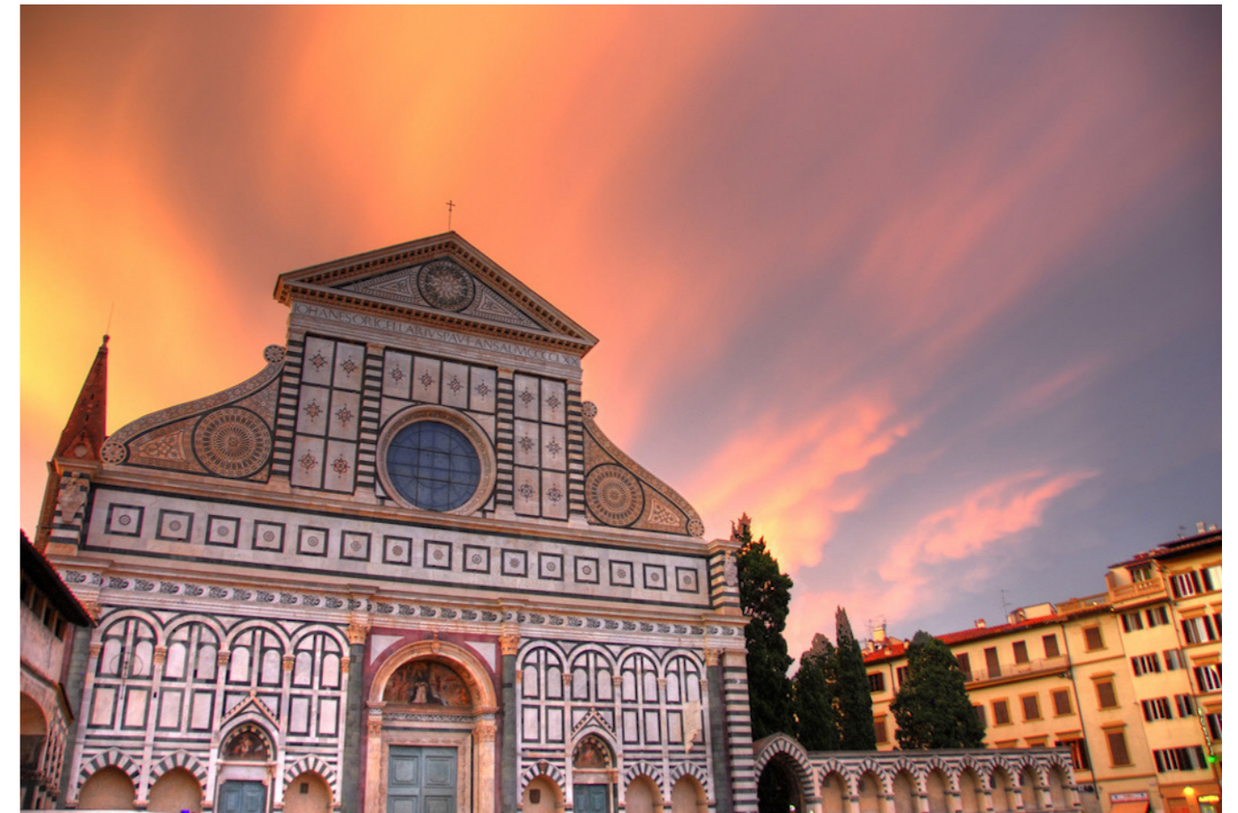
Fig.2.2 facciata della basilica di Santa Maria Novella a Firenze, con ingresso laterale che porta al chiostro Verde.
