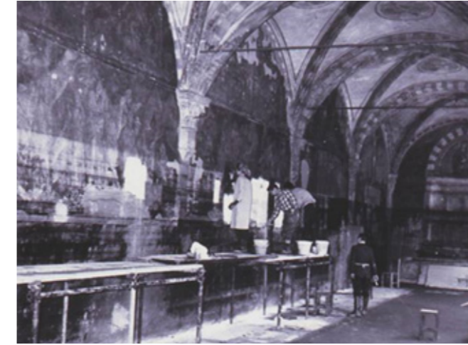
Fig. 2.13 Musei di Santa Maria Novella, chiostro Verde, particolare del lato Ovest dopo alluvione del 1966, quando il livello dell'acqua ricoprì la parte bassa degli affreschi per circa 1 m.
