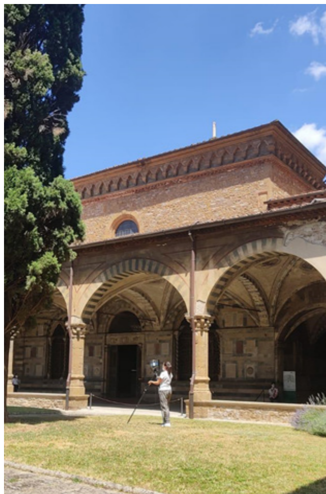
Fig. 3.3 fasi del rilievo laser scanner.
