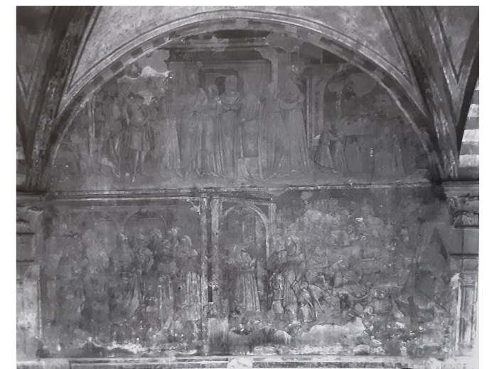
Fig. 2.5 Museo di Santa Maria Novella, lato Ovest, terza campata. Foto storica degli anni Trenta (?): residui delle finte colonne e dell'inconcrincatura.
