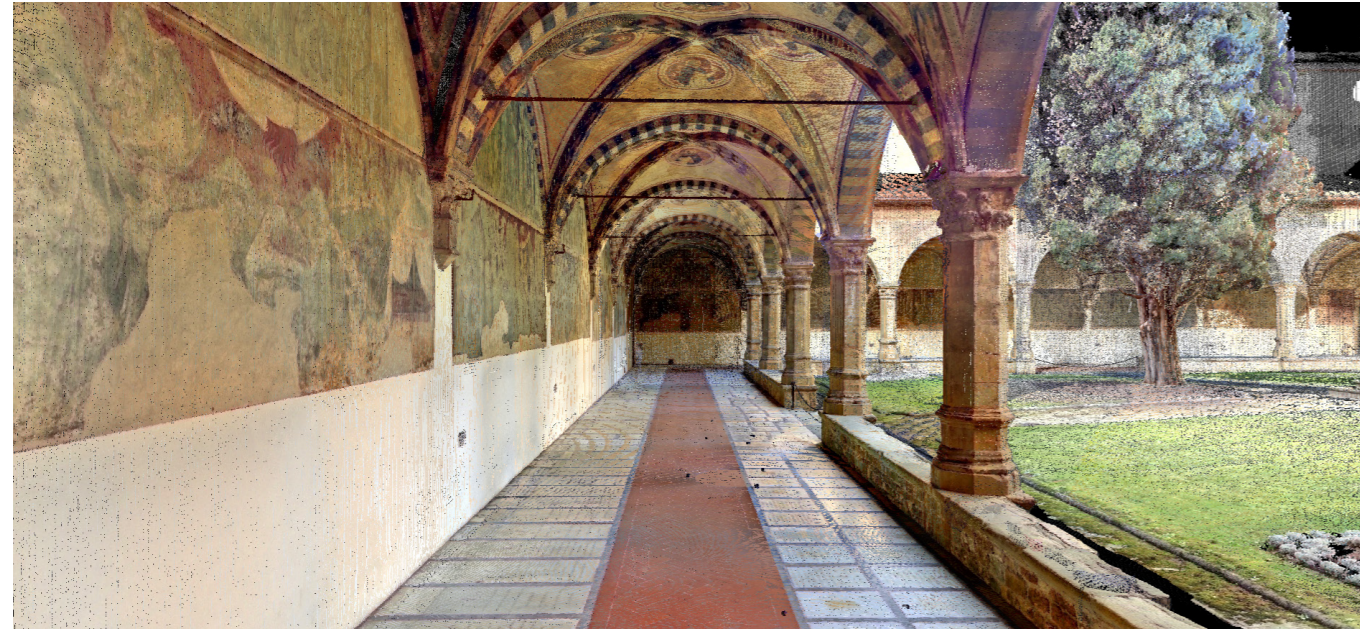
Fig. 2.3 vista prospettica da nuvola di punti laser scanner del lato Sud del chiostro Verde in Santa Maria Novella.
