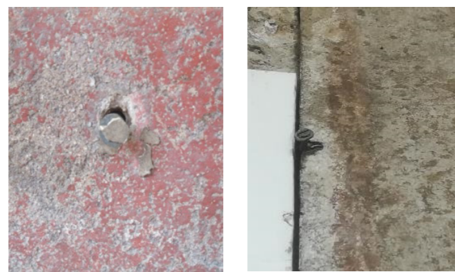
Fig.2.22 cedimento delle viti e delle staffe ad esse sugli affreschi del chiostro Verde.
