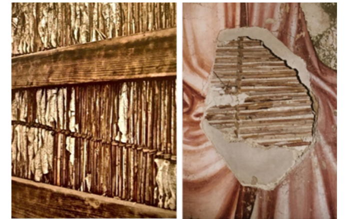
Fig. 1.4 affreschi staccati "Le storie di Sant'Orsola" (Treviso) collocati su un supporto ad incanniccato e gesso.
