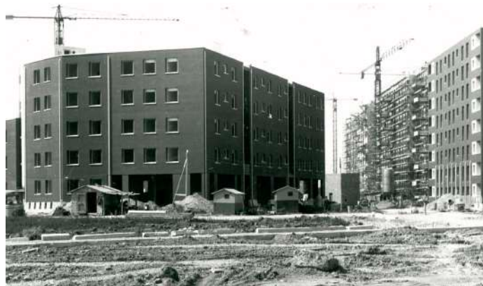
Fig. 1- Pilastro in 1966. Archivio ACER Bologna
