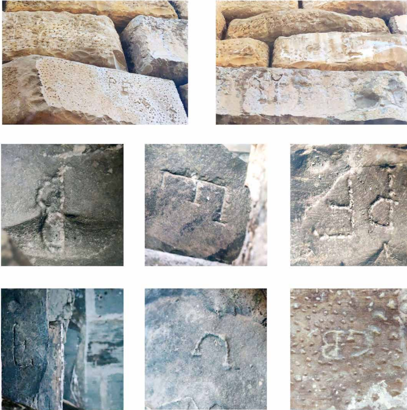
Fig. 113 - Rondò di Bacco; nella parte conclusiva realizzata dal Poccianti si osserva la presenza di contrassegni di lapicidi; (sopra) nei conci che affiancano la nicchia; (sotto) nel lato superiore e frontale dei conci del basamento. Rondò di Bacco; stonecutters' marks can be observed in the concluding part created by Poccianti: (above) in the ashlars flanking the niche; (below) in the upper and front side of the base ashlars.
