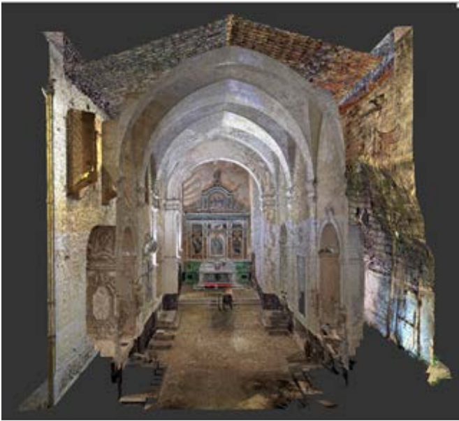
Figura 3: Madonna di Tutte le Grazie. Vista prospettica dell'interno. La parete rocciosa esterna mostra i filari del tagli dei conci di calcarenite.
