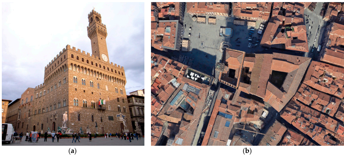
Figure 4. (a) The main façade of the Palazzo Vecchio in Piazza della Signoria; (b) the structural aggregate of Palazzo Vecchio.
