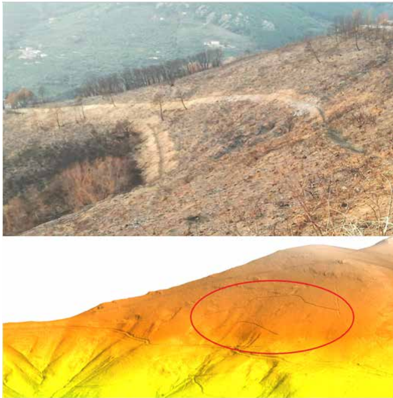
Figura 4.22. In alto - fossi di guardia realizzati sui Monti Pisani dalla Regione Toscana per regimare le acque e ridurre l'erosione dopo l'incendio del settembre 2018. In basso - elaborazione del DTM da Lidar per l'analisi modellistica della loro efficacia (fonte: Calvani 2019)
