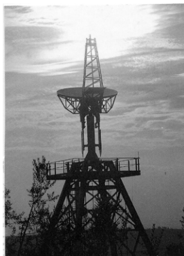
Figura 45 – La stazione radar meteorologica di Montagnana (Montespertoli, Firenze). Il sito di Montagnana è stato scelto tenendo conto della complessa orografia del territorio cercando di garantire la corretta visibilità delle precipitazioni in prossimità del suolo, minimizzando al tempo stesso gli echi non desiderati per riflessione dai rilievi.
