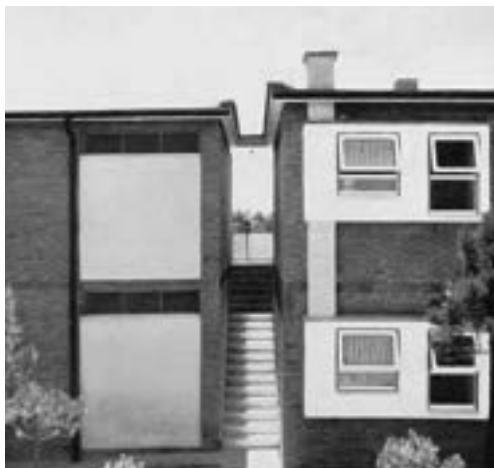
Esterni delle tipologie residenziali (da «Costruire» Gennaio-Maggio 1962)
