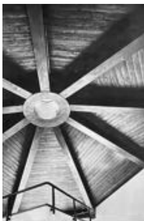
Vedute interne, (da «L'Architettura cronache e storia» Gennaio 1963 e Abitare Giugno 1963)
