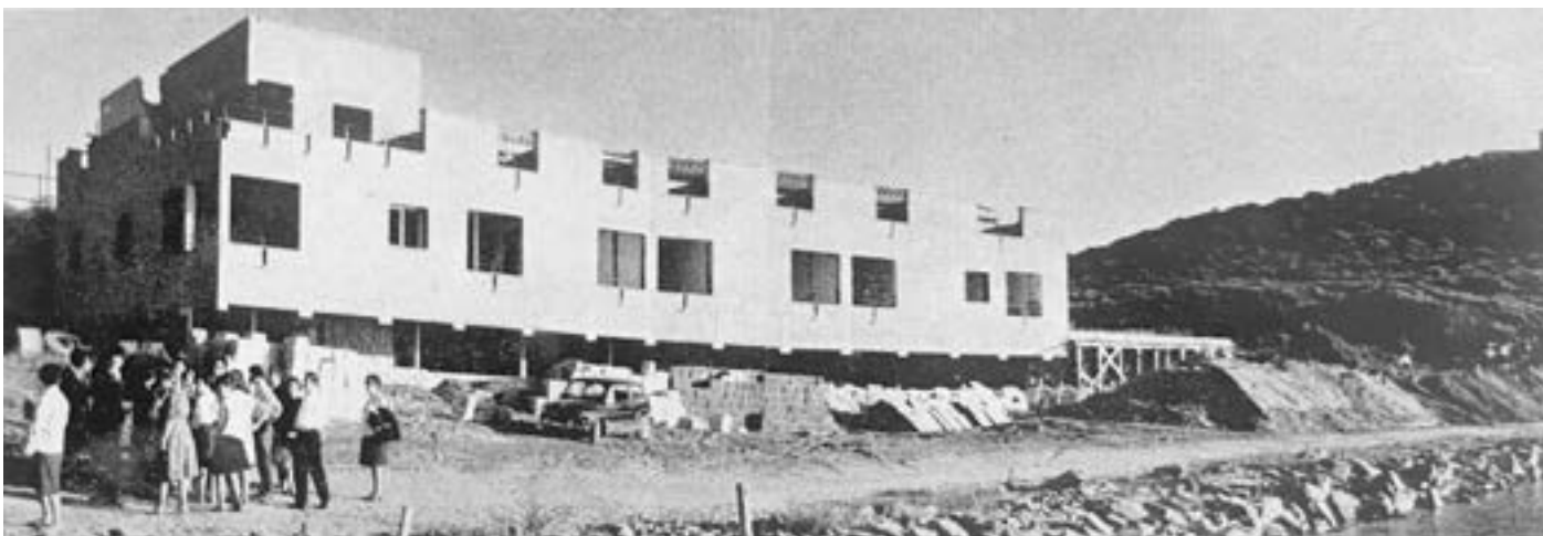
Costruzione del primo blocco nord (da «Casabella», Gennaio 1964)
