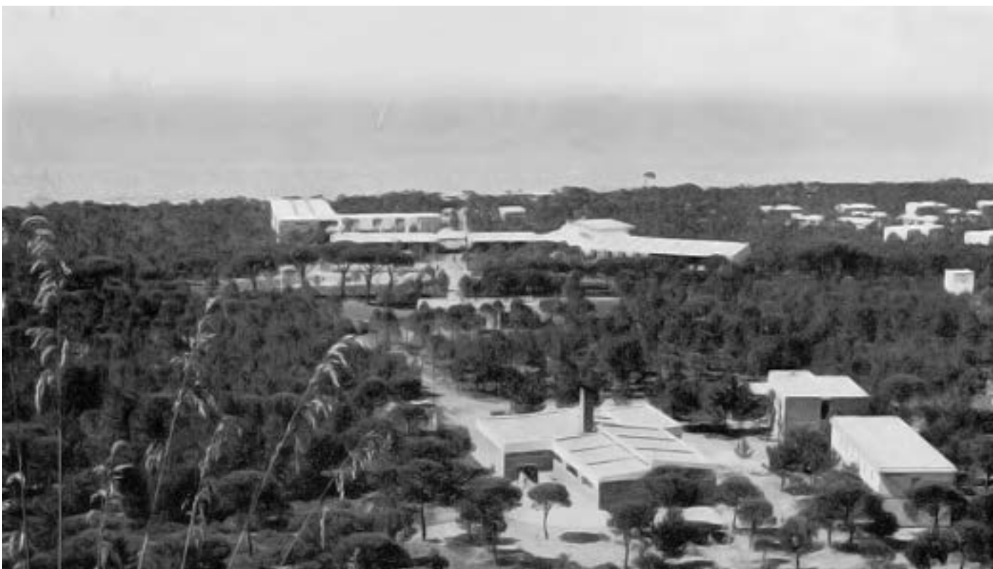
Fotografia aerea dell'area di Riva del Sole (da «Costruire» Gennaio- Maggio 1962)
