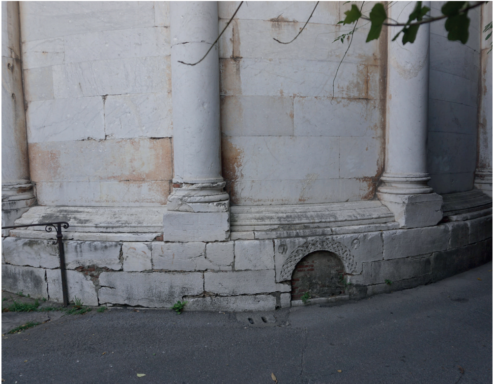
Fig. 51. Santa Maria Forisportam, Lucca: basamento del perimetro absidale
