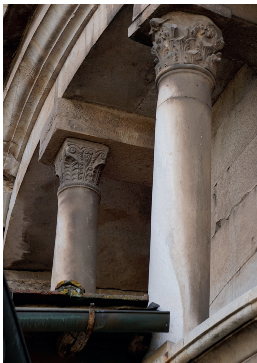
Fig. 49. Santa Maria Forisportam, Lucca: estremità sinistra della loggia absidale
