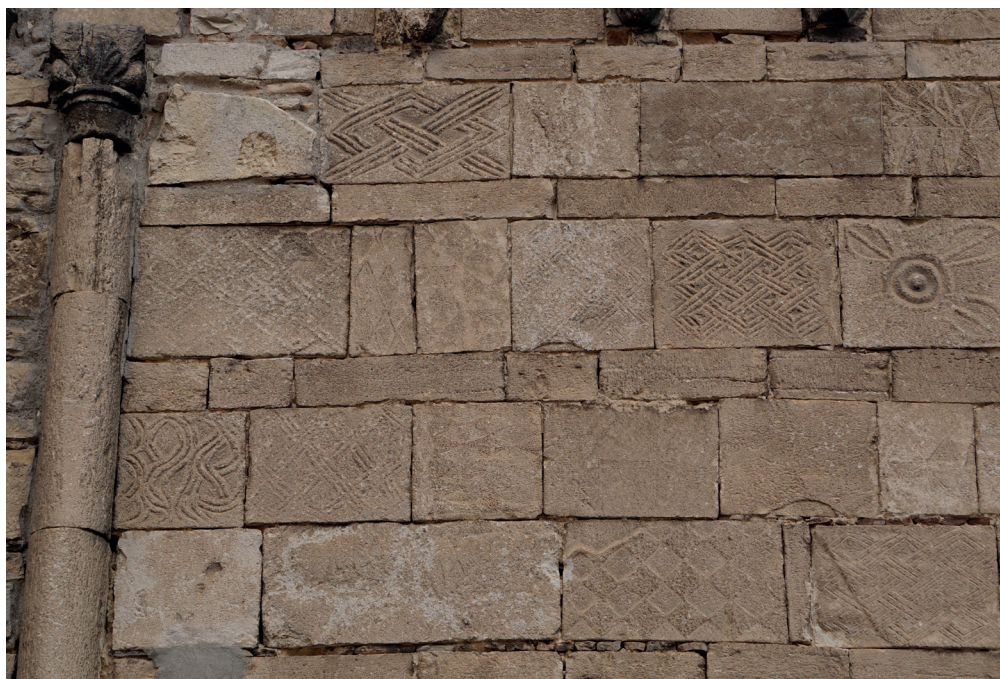
Fig. 1. Guardialfiera, cattedrale: parato pseudoisodomo, fianco occidentale dell'edificio
