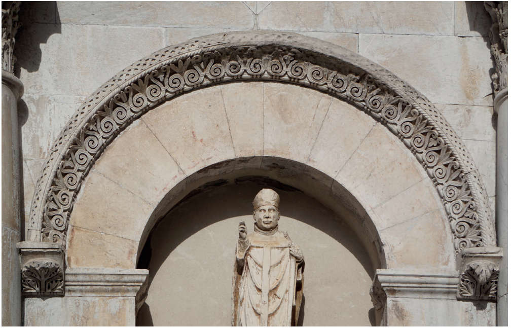
Fig. 47. Santa Maria Forisportam, Lucca: archivolto, portale di facciata destro
