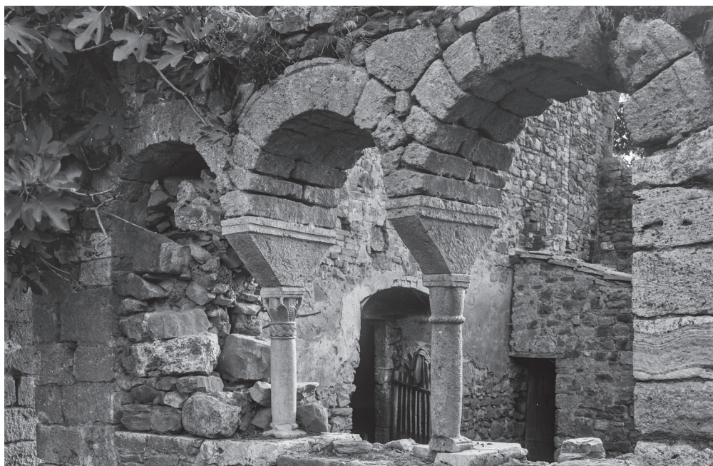
Fig. 35. Castelnuovo dell'Abate (Montalcino), abbazia di Sant'Antimo: colonne di reimpiego, trifora destra della sala capitulare
