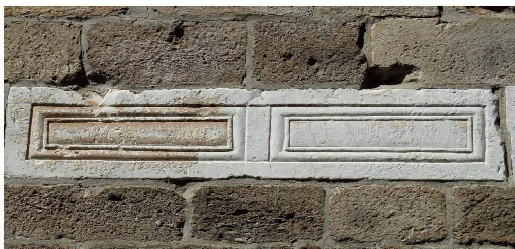
Fig. 32. Lucca, San Frediano: rilievo incluso entro il parato esterno della cappella Buonvisi, fianco meridionale della basilica
