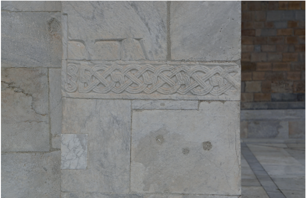
Fig. 21. Pisa, Duomo: fianco della tribuna absidale, semipilastro dell'angolo settentrionale, lato sud
